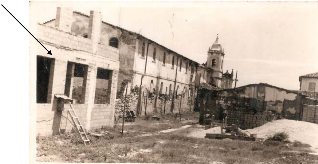
(Fig. 66) Estrutura de concreto para onde se transferiram as irmãs. Década de 1970 (início) Fotografia: autor desconhecido Acervo particular
