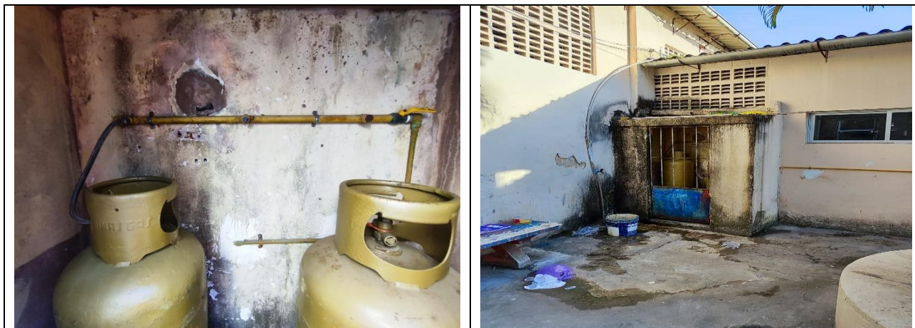
Figura 18 – Instalações técnicas da edificação: gás liquefeito
