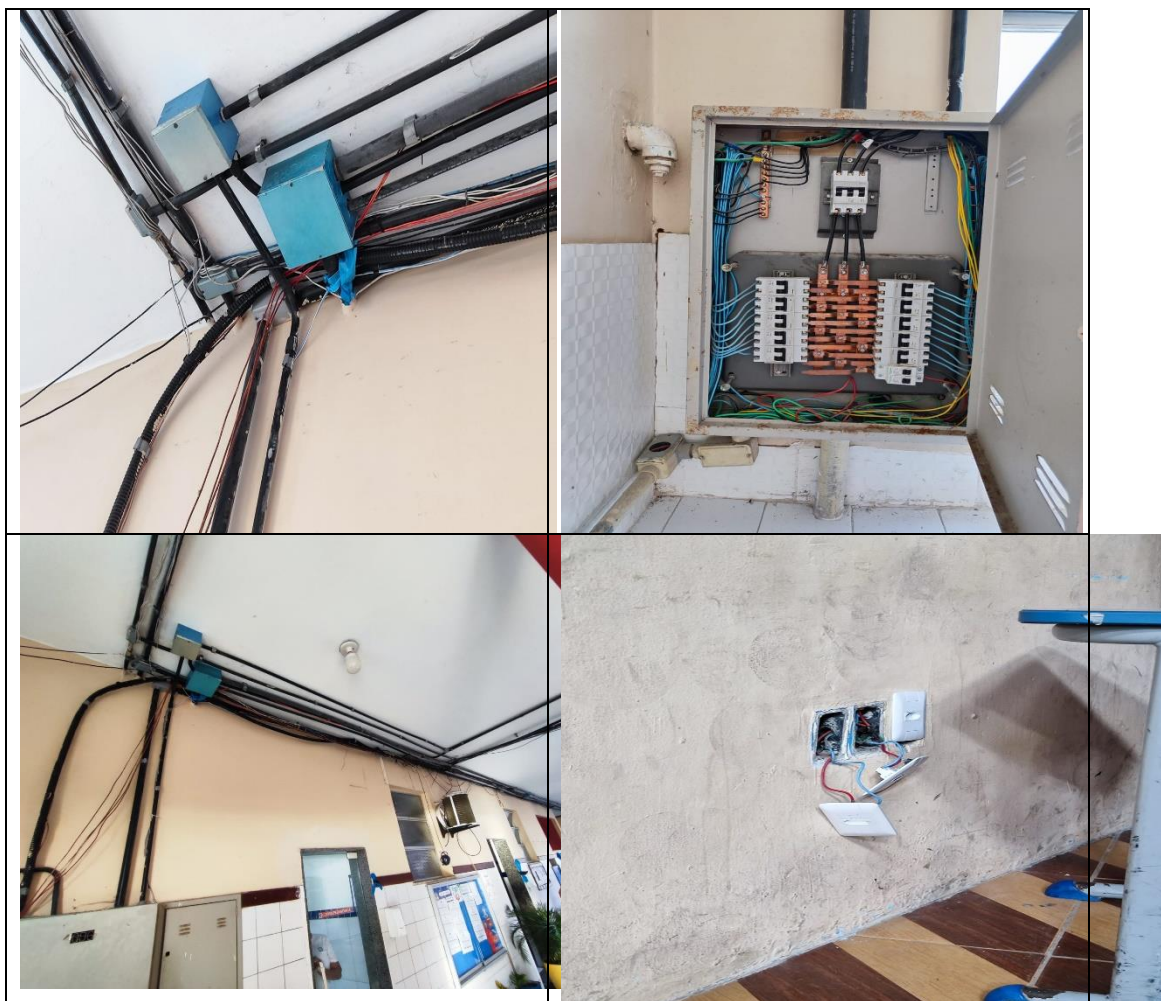
Figura 20 – Instalações técnicas da edificação: pontos críticos
