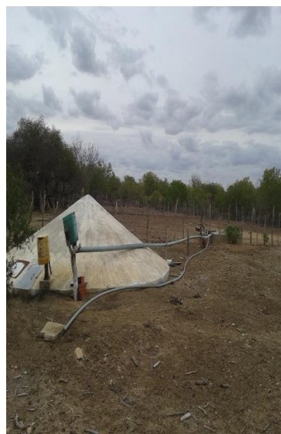
Cisterna calçadão com sistema de encanamento para levar água da cisterna ao bebedouro dos animais
