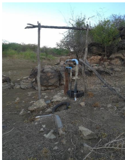
Poço existente nas terras do Sr. Bilú com vazão de 30 mil litros por hora
