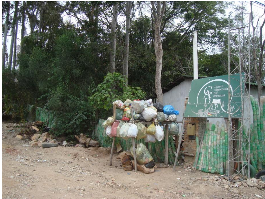
Figura 07 - Lateral da fachada da sede do GAP
