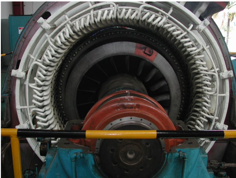
Figura 22 – Visão frontal de compensador síncrono ilustrando o estator.
