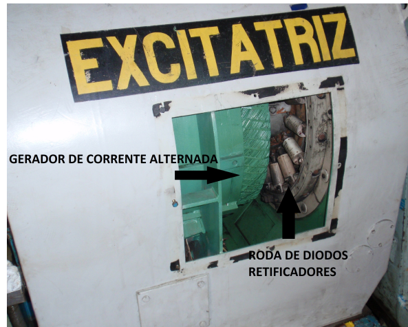
Figura 17 – Sistema de excitação sem escovas.
