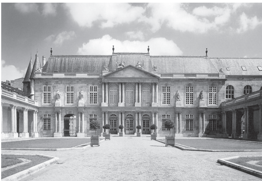
FIGURA 117: Sóbria fachada do Hôtel de Soubise, projetada pelo francês Pierre Alexis Delamair (1676-1745) e construída entre 1704 e 1707. Fotografia elaborada por Achim Bednorz.
