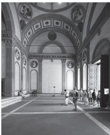
FIGURA 3: Fotografia voltada para o eixo transversal da cavidade interna da capela projetada por Brunelleschi, em Florença. Fotografia elaborada pelo autor em 2007.
