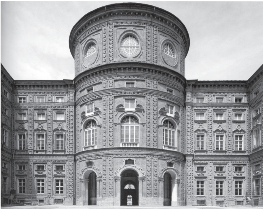
FIGURA 82: Fachada voltada para o pátio interno do Palazzo Carignano, de Guarino Guarini, 1679. Fotografia elaborada por Pino dell'Aquila.
