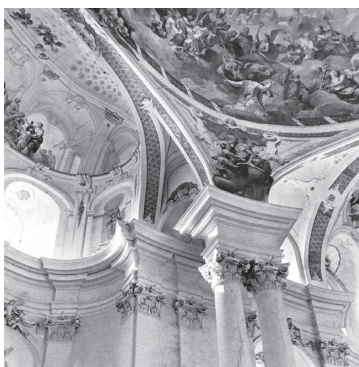
FIGURA 148: Detalhe da estrutura da Igreja Abacial de Neresheim. Destaque para a estranha disposição das colunas, arcos, abóbadas, em sua consonância com a exuberante ornamentação rococó.
