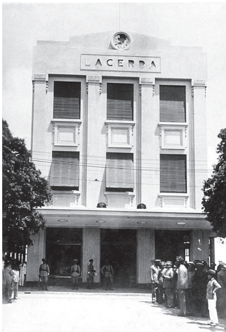
IMAGEM 8 – Fachada Praça Municipal em Concreto
