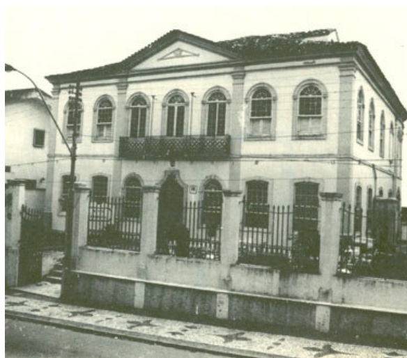
Figura 9 SOBRADO DA LADEIRA DA BARRA Século XIX Inventário de Proteção do Acervo Cultural
