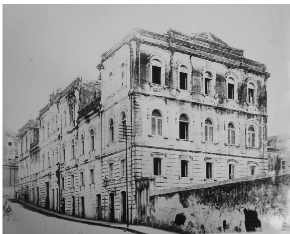
Figura 9 Solar Jonathas Abbott – 1ª reforma geral Fotografia AHEBA-UFBA
