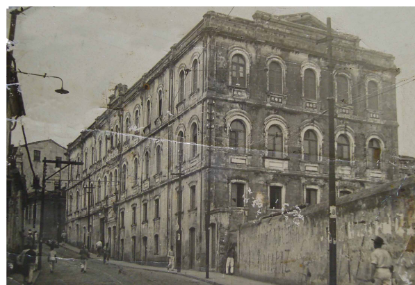
Figura 10 Solar Jonathas Abbott – 2ª reforma geral Fotografia AHEBA-UFBA
