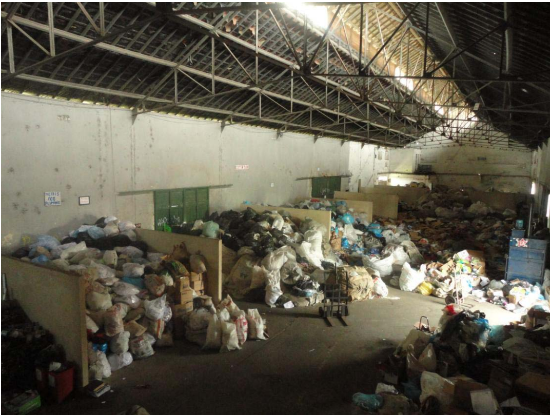
Figura 16 – Galpão de coleta seletiva da Camapet Fotografia: João Aires, 2011
