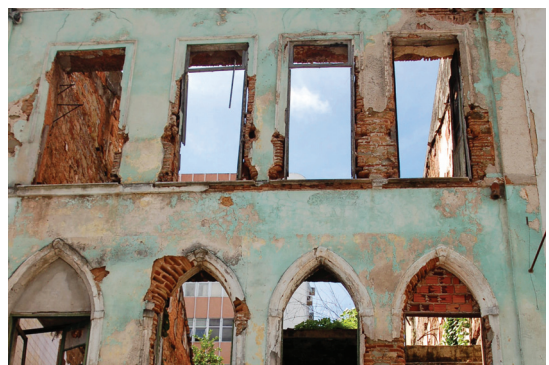
Fig. 138 — EDIFÍCIOS, Cidade Baixa, Salvador 2008
