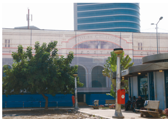
Fig. 35 – Prédio (em reforma) dos Correios, Luanda, 2008
