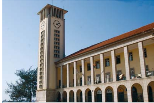
Fig. 91 – Edifício da Alfândega , Luanda, 2008
