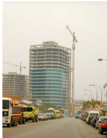
Fig. 93 – Edifícios em construção , Luanda, 2008
