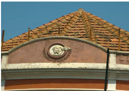
Fig. 53 – Detalhes de edifícios, Luanda, 2007
