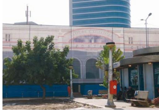
Fig. 35 – Prédio (em reforma) dos Correios, Luanda, 2008
