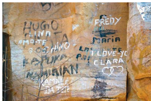
Fig. 76 – DETALHES de muros, Luanda, 2007
