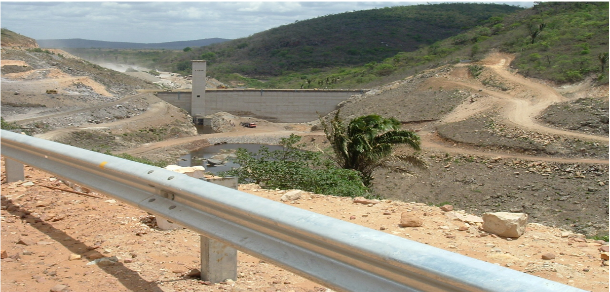
Figura 13. Vista parcial do lago da barragem de Pindobaçu, em construção (Fevereiro de 2005).
