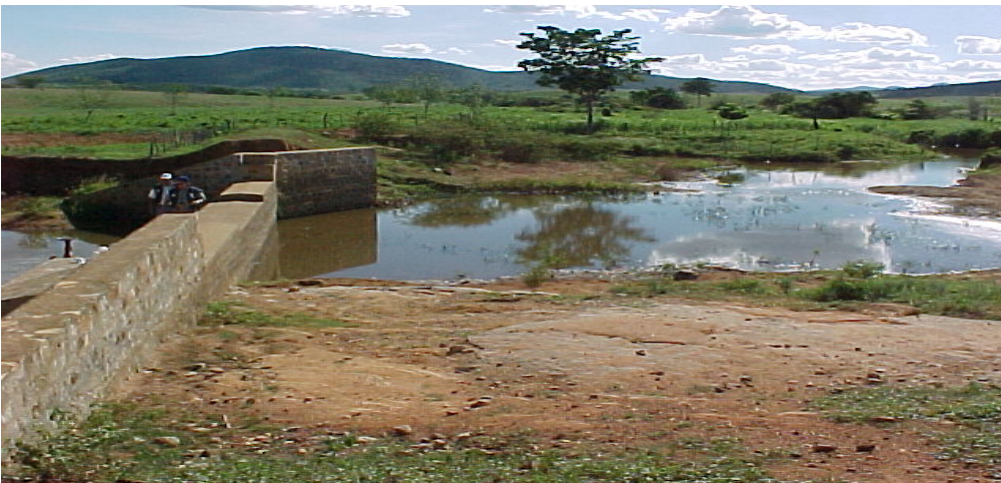
Figura 12. Barragem de pequeno porte, Rio Aipim – município de Pindobaçu.
