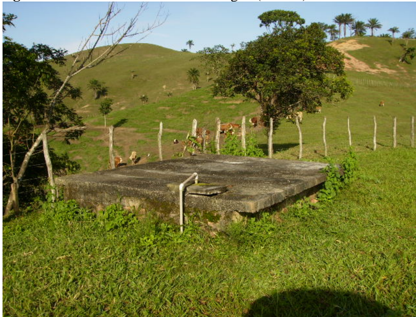
Figura 8: Reservatório central de água
