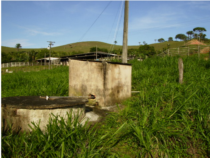
Figura 7: Fonte de abastecimento de água (natural) com a bomba – área da capineira
