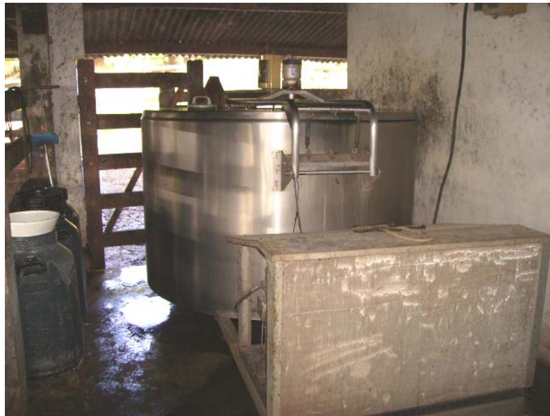
Figura 14: Tanque de resfriamento e seus componentes
