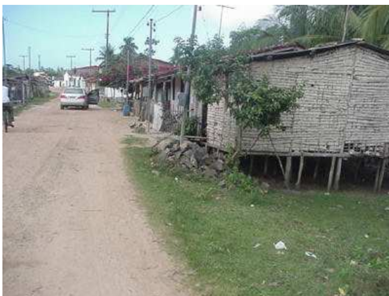
Figura 14 – As ruas de Ilha d’Ajuda não são calçadas ou asfaltadas.
