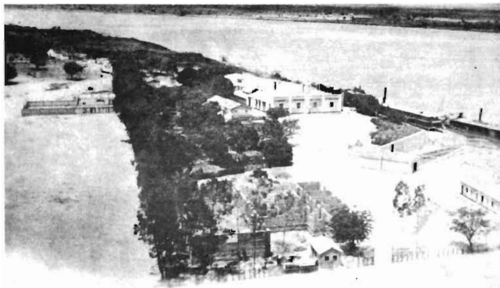
Antiga Sede e Estaleiros da Empresa Viação do São Francisco. Demolida.
