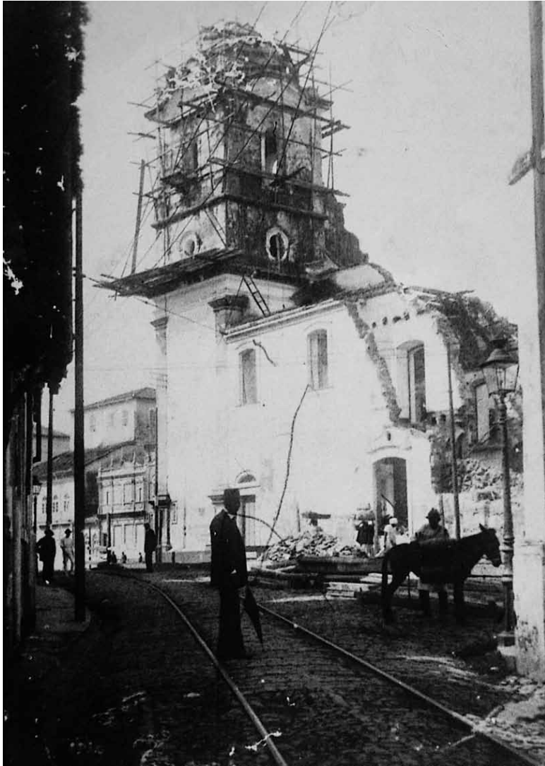
50. Demolição da Igreja de São Pedro Velho para abertura da Av. 7 de Setembro
