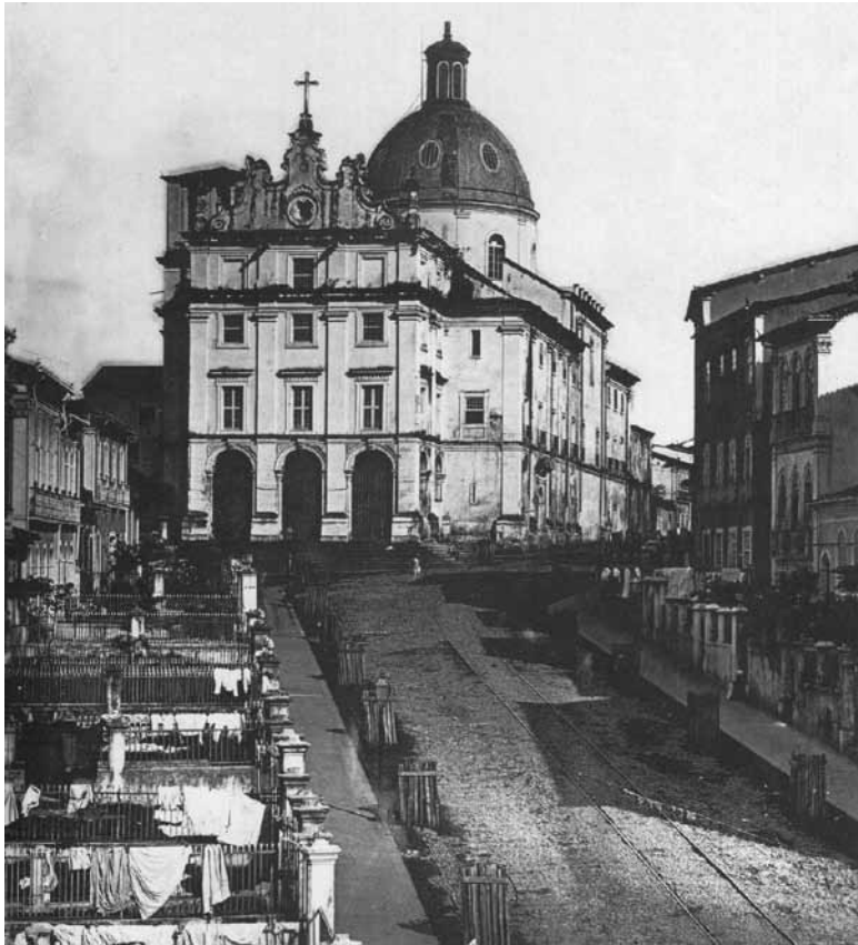
47. Ladeira de São Bento, antes das intervenções de J. J. Seabra - 1884 - foto de Marc Ferrez
