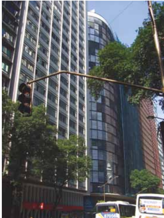
Figura 74 e 75. Prédios da Avenida Rio Branco
