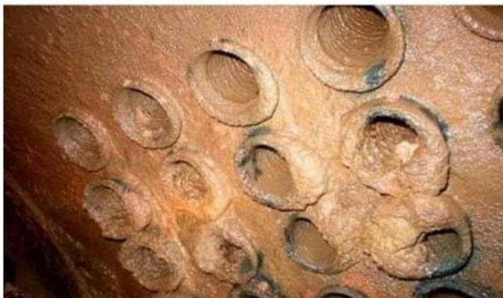
**Figura 23:** Exemplo de incrustações em um trocador de calor.
