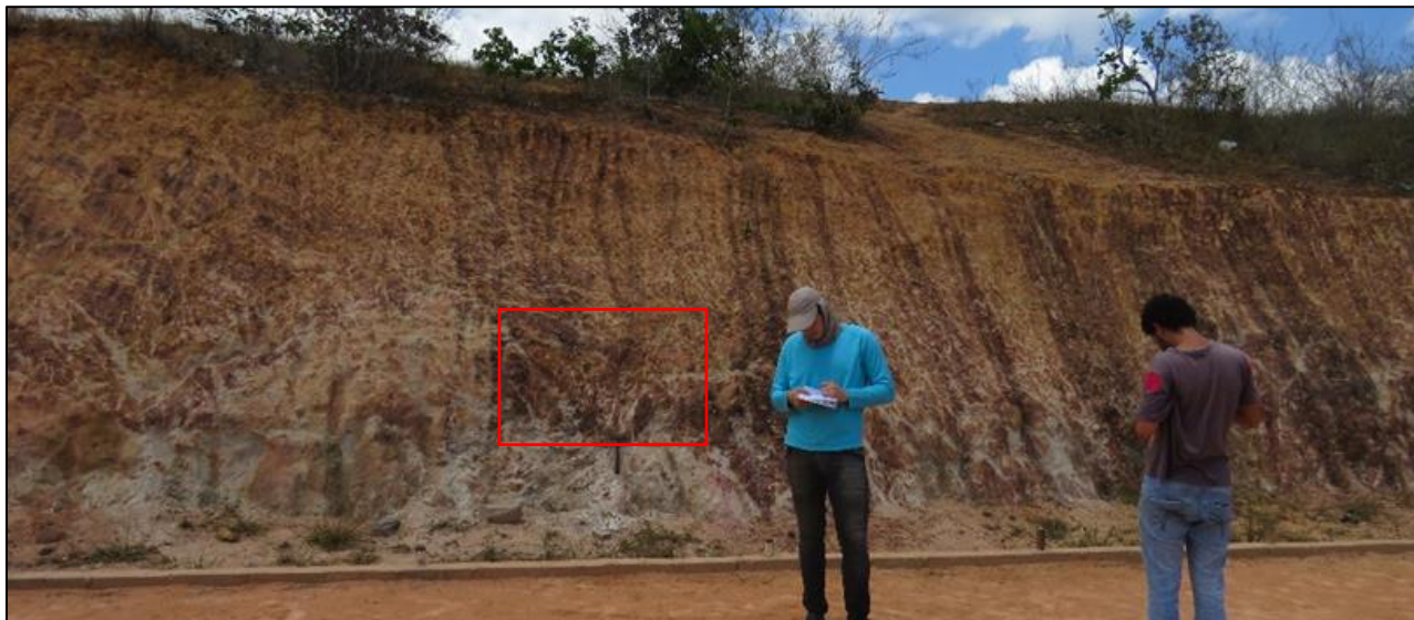
Fotografia 5 - Corte de estrada com presença de uma capa ferruginosa marcada pelo polígono vermelho.
