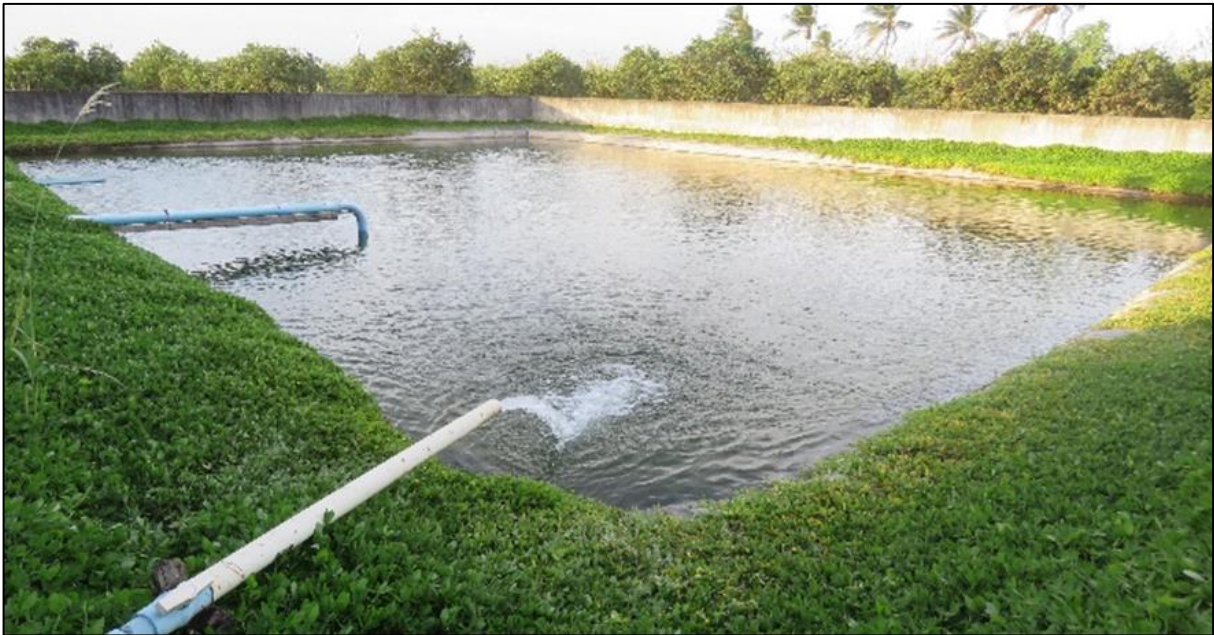
Fotografia 8 - Abastecimento de reservatório de água, pelo poço tubular BN01, para uso na irrigação. Coord. X:597676 e Y:8739090.
