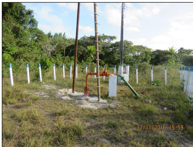
Fotografia 11 - Poços Tubular, BN07, no município de Esplanada, na localidade de Negro do Mato. Coordenadas X:8692997 e Y: 615429.
