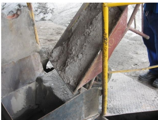
Figura 64: Transporte de agregados para preparo do concreto na FPM 03
