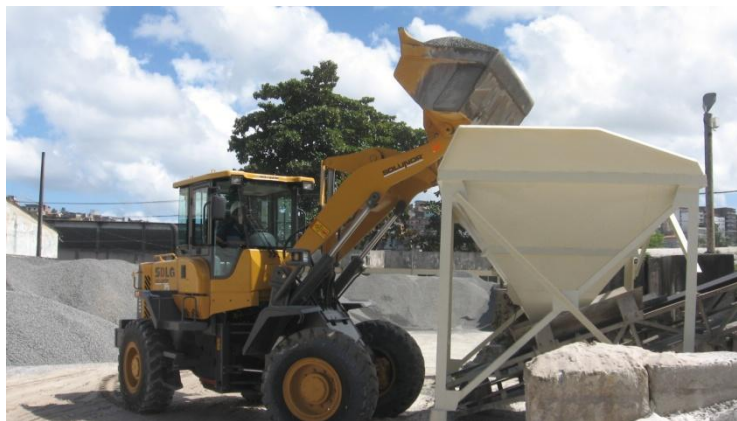
Figura 12: Pá carregadeira transportando agregados até a tremonha
