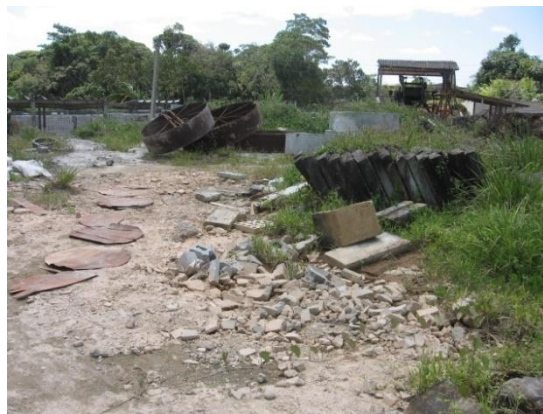
Figura 93: Área ociosa na fábrica de pré – moldados 06
