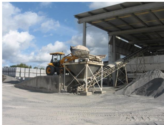
Figura 58: Pá carregadeira descarregando areia na tremonha – FPM 04
