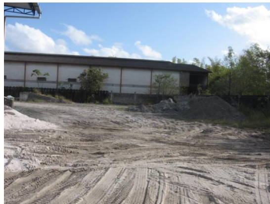
Figura 89: Área ociosa na fábrica de pré – moldados 02
