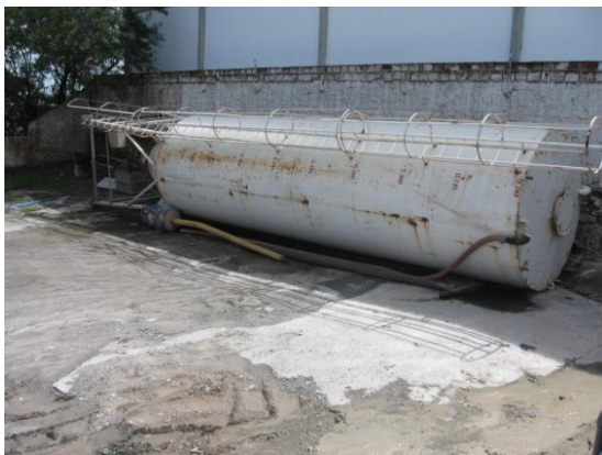
Figura 33: Área ociosa na Central 01 na qual está sendo armazenado equipamento fora de uso.
