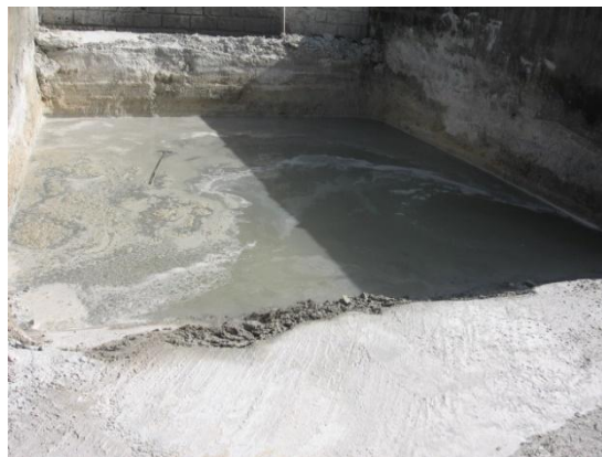
Figuras 24 e 25: Tanque de decantação de águas provenientes da lavagem dos caminhões betoneira nas centrais de concreto
