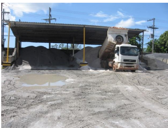
Figura 22: Baias de agregados cobertas nas centrais de concreto
