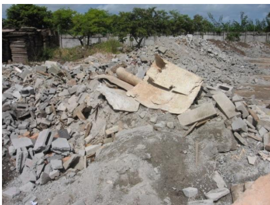
Figura 86: Resíduos de Concreto – FPM 03
