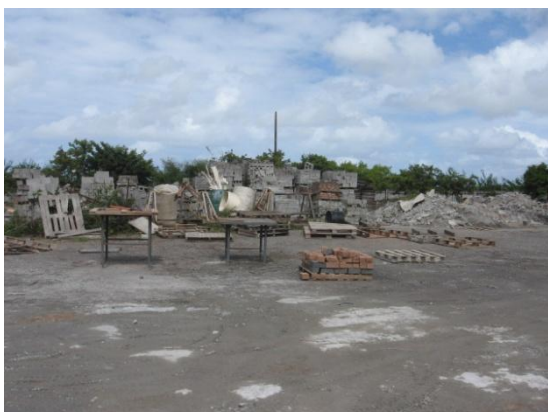
Figura 90: Área ociosa na fábrica de pré – moldados 03
