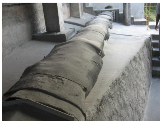
Figura 48: Transporte do cimento via correia transportadora coberta – FPM 01
