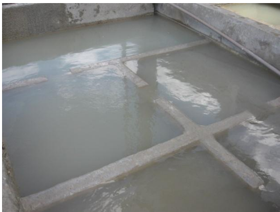
Figuras 24 e 25: Tanque de decantação de águas provenientes da lavagem dos caminhões betoneira nas centrais de concreto
