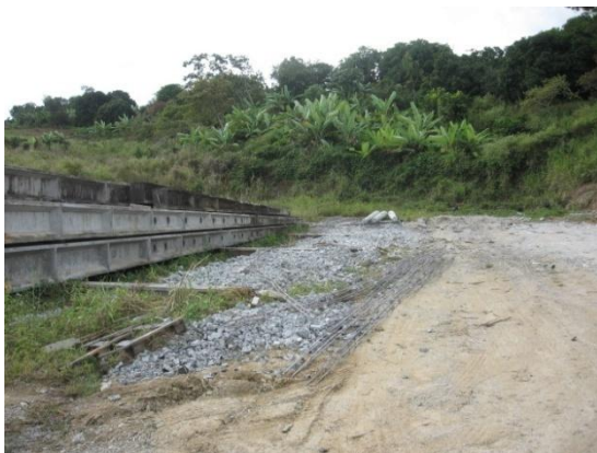
Figura 92: Área ociosa na fábrica de pré – moldados 05
