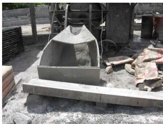
Figura 65: Transporte de agregados para produção de concretos FPM 06
