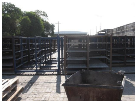
Figura 91: Área ociosa na fábrica de pré – moldados 04
