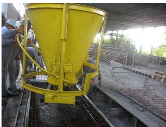
Figuras 52: Transporte do concreto para as linhas de produção - FPM 01
