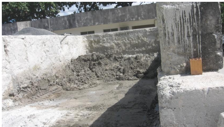
Figura 46: Área para armazenamento de resíduo de concreto na central 06
