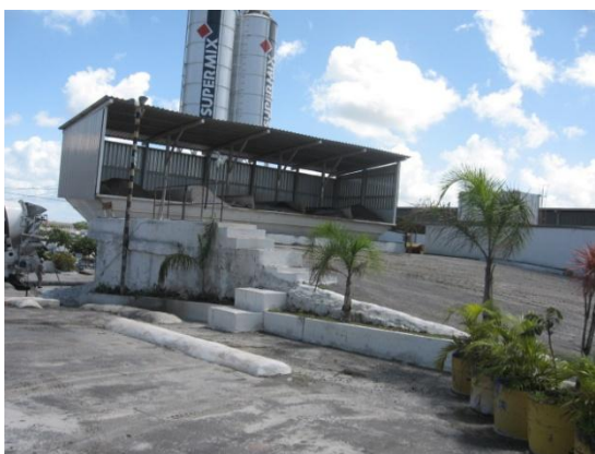
Figura 10: Silos de Agregados
