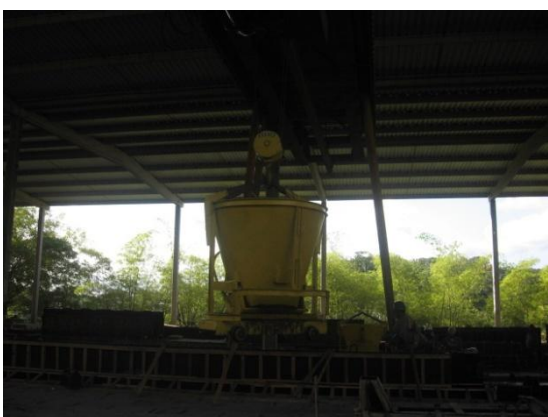
Figura 51: Transporte do concreto para a fabricação dos produtos - FPM 01
