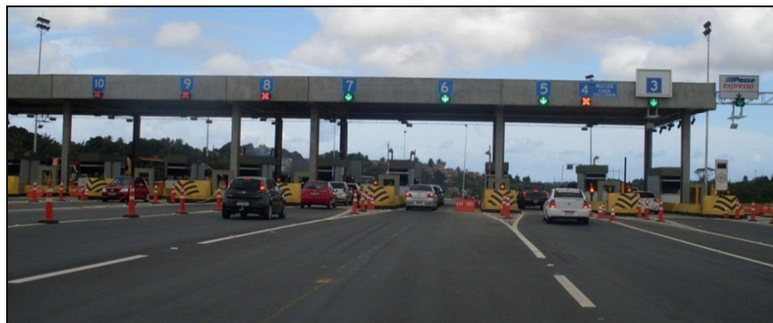
Figura 55: Praça de pedágio localizada no km-08 da BA-526
