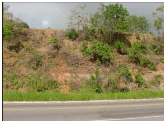
Figura 42: Afloramento de rocha alterada do Embasamento Cristalino às margens da rodovia BA-526
