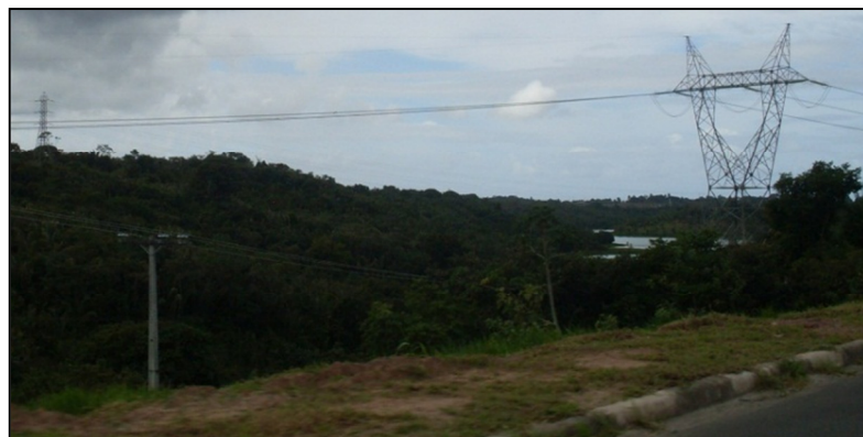
Figura 46: Linha de transmissão de energia às margens da Represa III do Rio Ipitanga e da rodovia BA-526.
