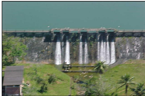
Figura 30: Represa e Barragem do Rio Ipitanga I
