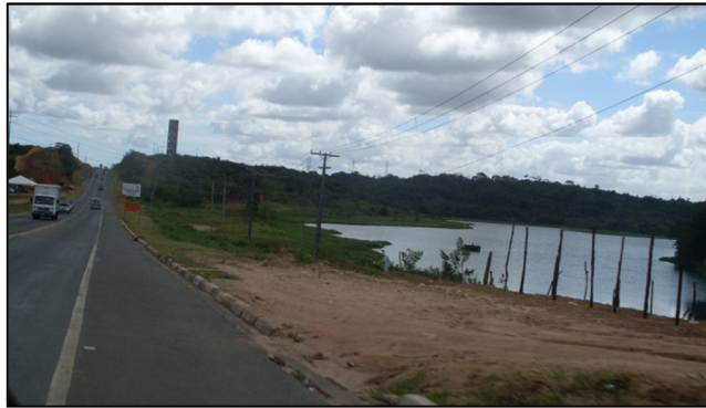
Figura 33: Rodovia BA-526, aterro da Barragem do Rio Ipitanga III, com vista para a Represa III do Rio Ipitanga.
