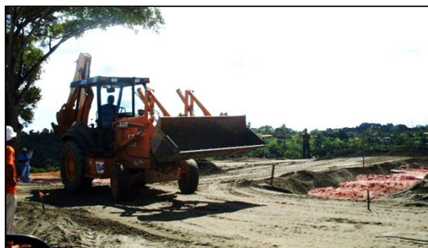
Figura 52: Loteamento habitacional em fase de implantação, próximo à Represa I do Rio Ipitanga.
