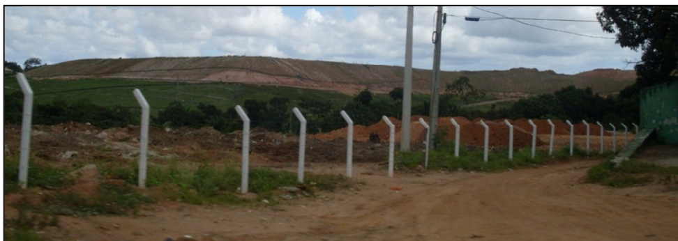
Figura 49: Aterro Metropolitano Centro, próximo à BA-526
