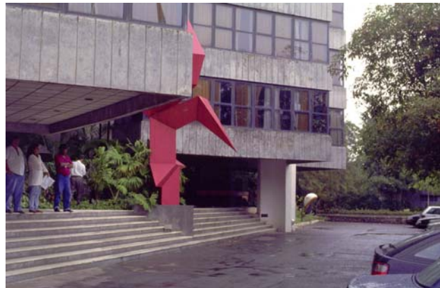
Fig. 45 Detalhe da entrada. Grandes balanços.
