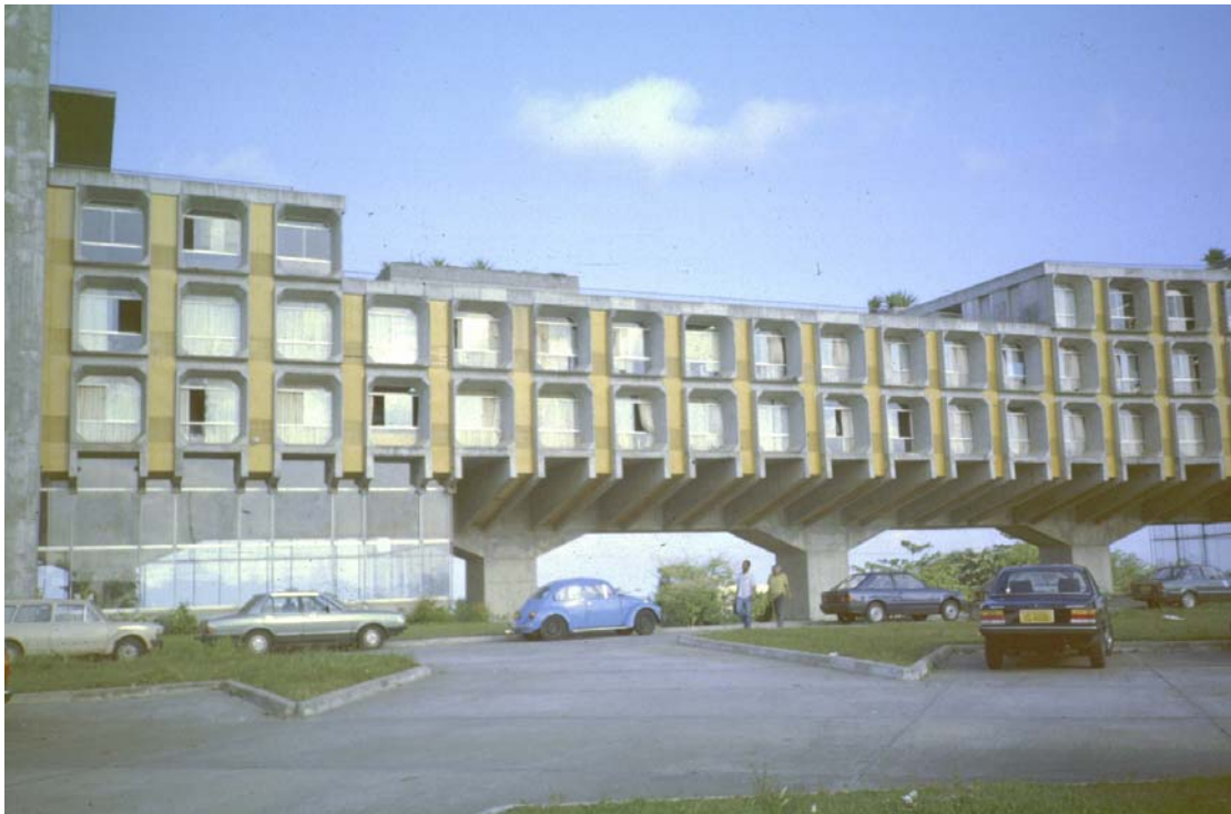
Fig. 42 Vista de uma Plataforma. A estrutura de viaduto supõe uma carga adicional futura.
