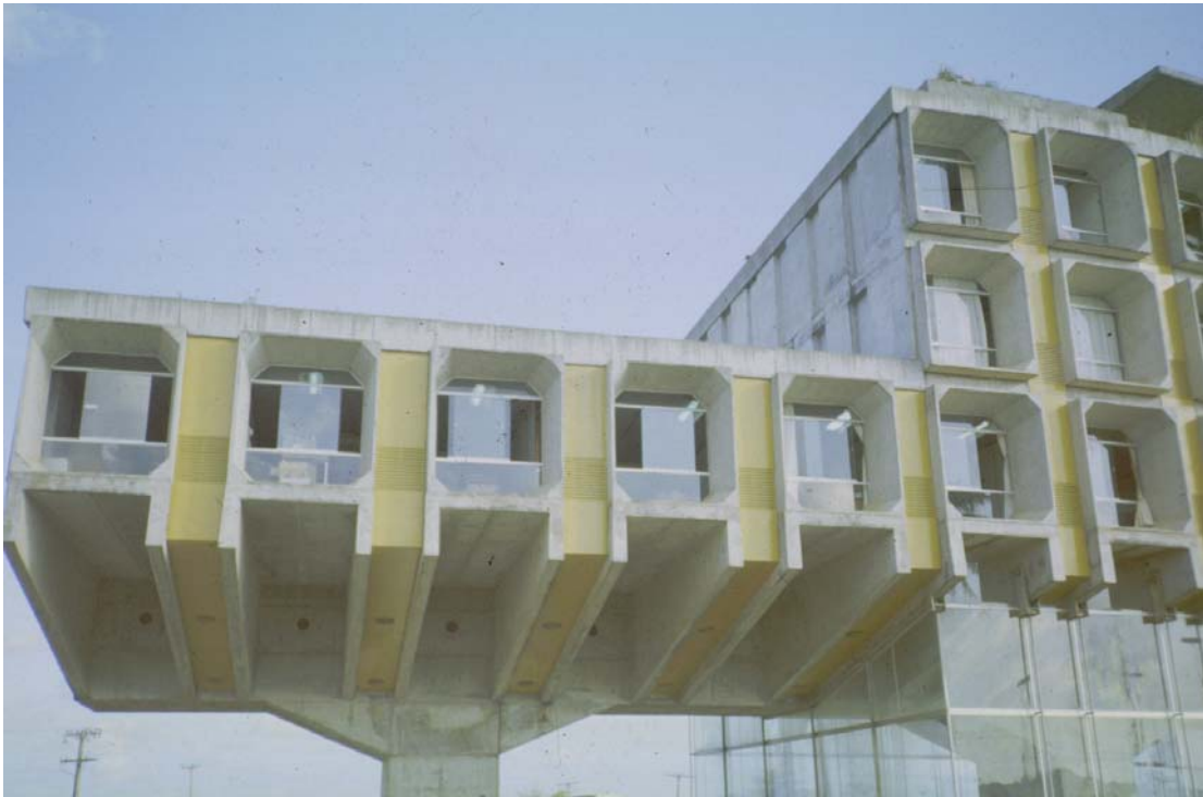
Fig. 41. Detalhe da Plataforma; note-se a desproporção entre a estrutura de suporte e o andar suportado. A impressão do inacabado como estética de uma arquitetura "em processo".
