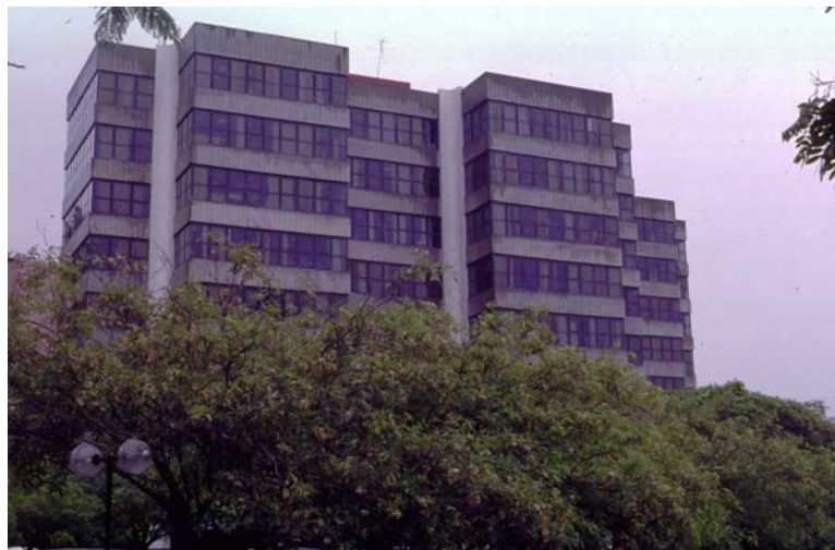
Fig. 46 Vista do prédio do DESENBANCO
