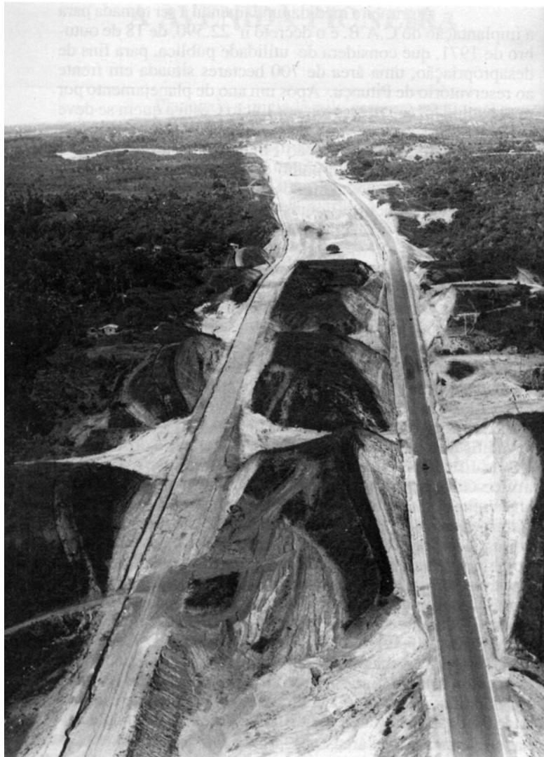
Fig. 16 A avenida Paralela ainda com os testemunhos de cortes e aterros sucessivos.
