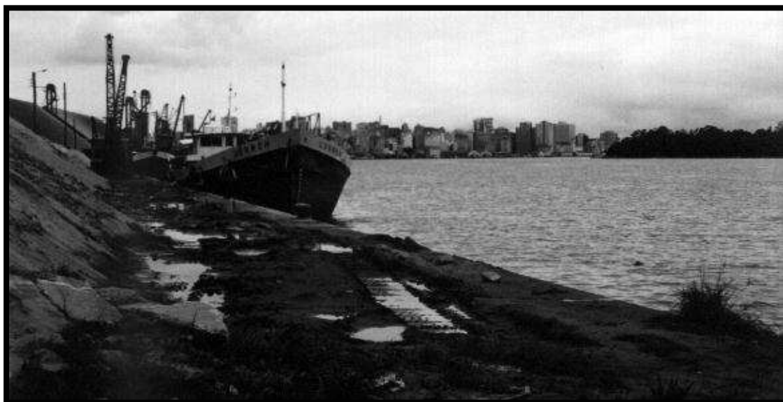
Ilust. 52 - Setor 2 – Armazenamento de Areia e Cascalho. Foto: Tais Trevisan.
