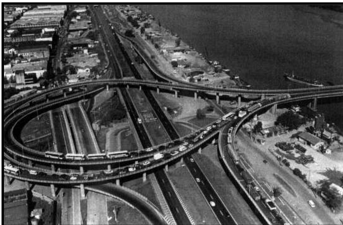
Ilust. 53 - Final do Setor 2 – Visão geral do Cais Navegantes e parte do Cais Marcílio Dias, após a Ponte. 1998. Fonte: Prefeitura de Porto Alegre.
