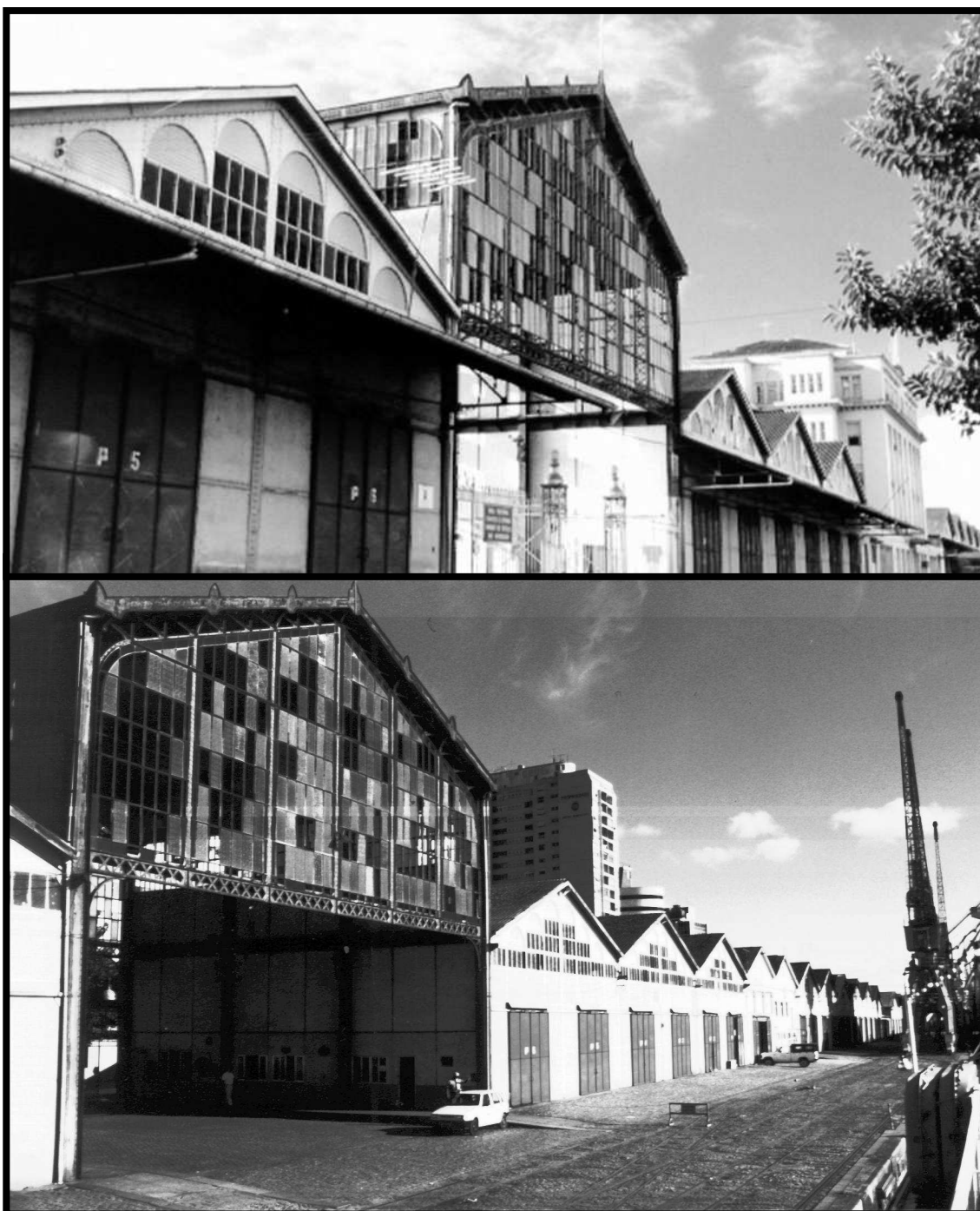
Ilust. 69-70 - Pórtico Central do cais do Porto Mauá, antes da restauração.
