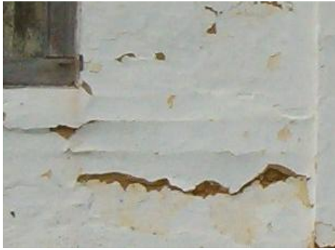
Figuras 5.13 e 5.14. Fissuras no reboco
