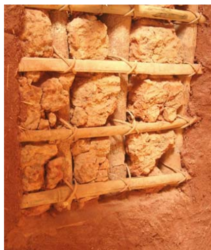
Figura 4.2. Parede de pau a pique
