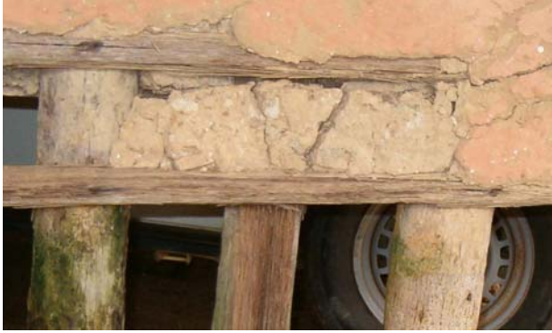
Figuras 5.11. Fissuras no enchimento causadas, entre outras coisas, por movimentação dos paus da trama
