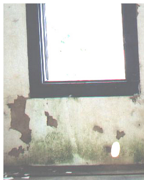
Figuras 5.30. e 5.31. Presença de microorganismos sobre a parede
