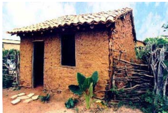
Figura 1.2 – Casa “popular” construída precariamente em pau a pique
