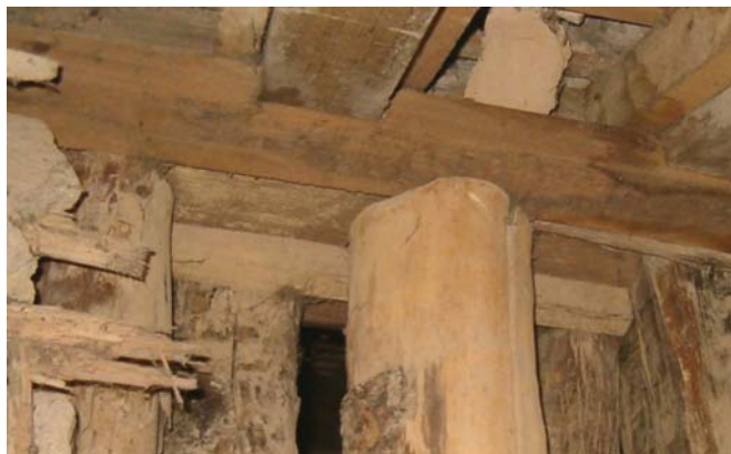
Figura 4.30. Paus verticais presos em ripa fixada no frechal
