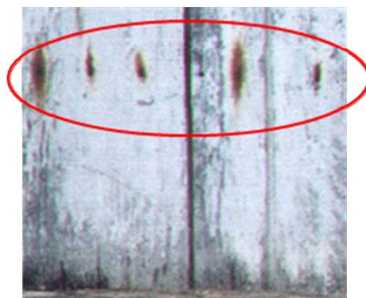
Figuras 5.29. Oxidação dos pregos na janela de madeira
