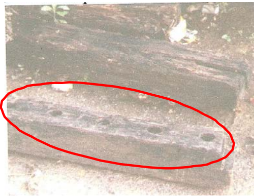
Figura 4.21. Furos para encaixe de paus verticais
