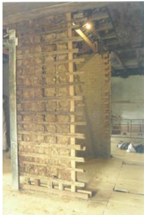
Figura 1.12 – Parede interna. Sobrado Ramalho. Tiradentes/ MG
