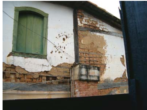
Figura 1.13 – Parede externa. Santana dos Montes/ MG
