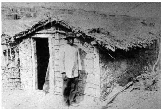
Figura 1.1 – Casa “popular” construída precariamente em pau a pique
