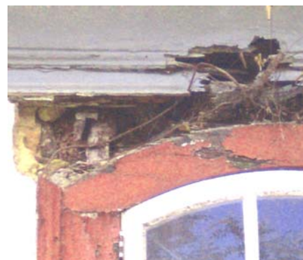
Figuras 5.20. Desprendimento de trecho da sobreverga devido à presença de vegetação de médio porte
