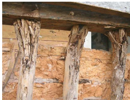
Figuras 5.25. Paus verticais da trama (deformados)
