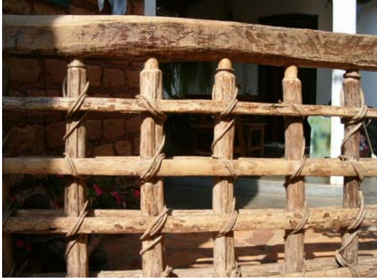
Figura 4.19. Paus verticais encaixados no frechal
