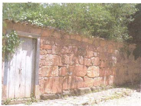
Figura 2.3. Muro de moledo
