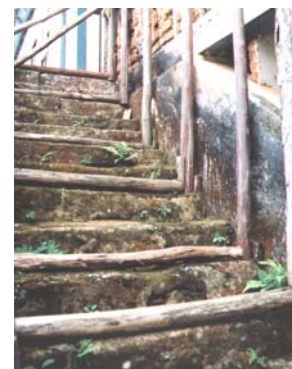
Figuras 5.32. Presença de microorganismos sobre a parede e nos pisos e espelhos da escada
