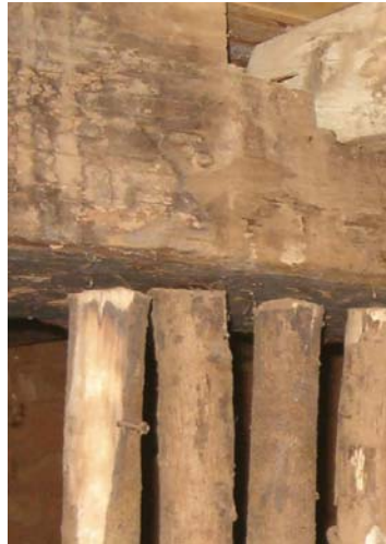
Figura 4.28. Paus verticais com faces superiores paralelas à face inferior do frechal
