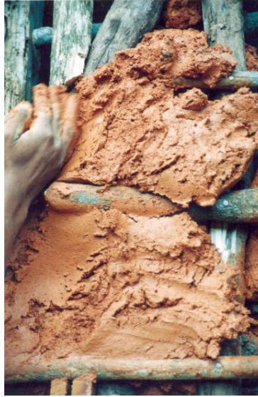
Figura 4.10. Marcas dos dedos gravadas durante o barreamento
