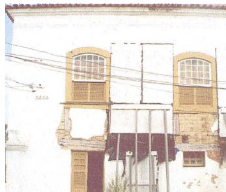
Figura 2.6. Edifício de adobe
