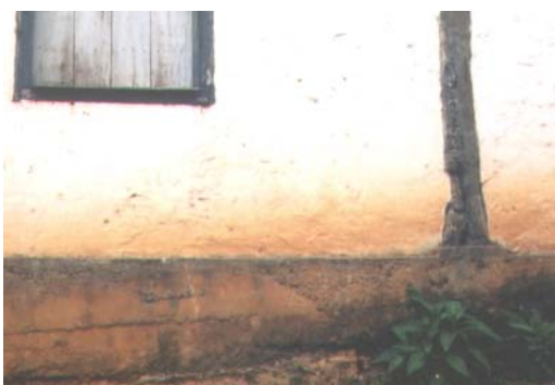
Figuras 5.9. Manchas de cor marrom devido à presença de terra no entorno do edifício
