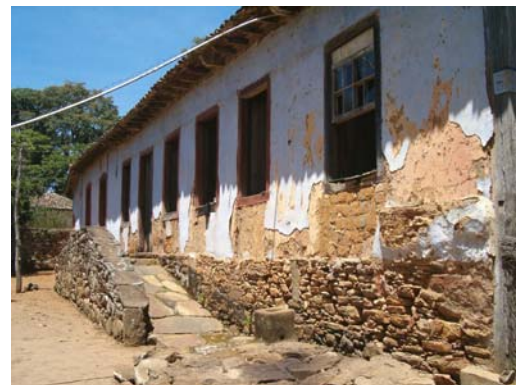
Figura 1.23 – Sede da Fazenda das Pedras
