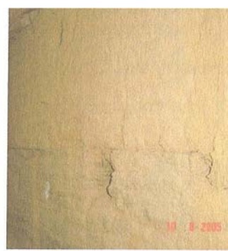
Figura 2.4. Parede de taipa de pilão
