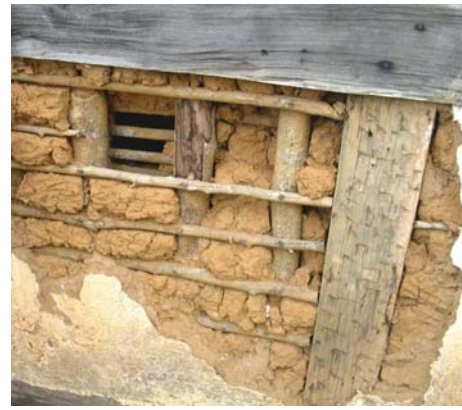
Figuras 5.16. Desprendimento de emboço e reboco
