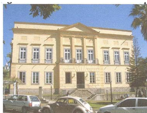
Figura 1.36 – Sede da Câmara Municipal
