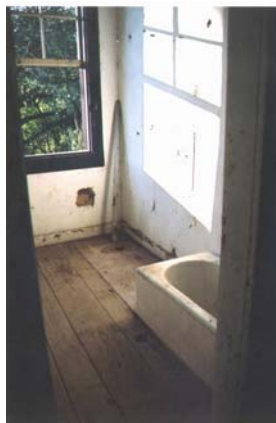
Figura 1.16 – Banheiro adaptado, no séc. XX, ao interior do edifício do séc. XVIII. Fazenda Ribeirão das Rosas. Juiz de Fora/ MG
