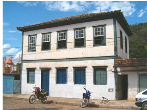
Figura 1.15 – Edifício com dois pavimentos. Distrito de Rosário de Minas. Juiz de Fora/ MG
