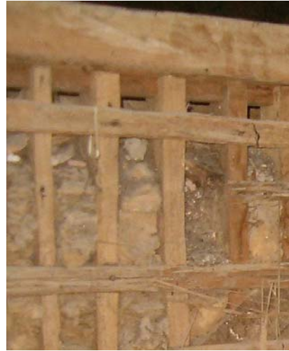
Figura 4.17. Trama constituída por paus serrados
