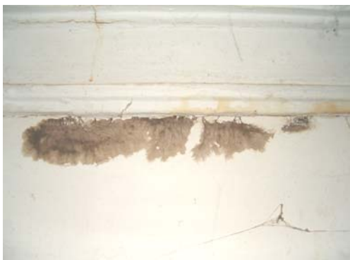
Figuras 5.30. e 5.31. Presença de microorganismos sobre a parede
