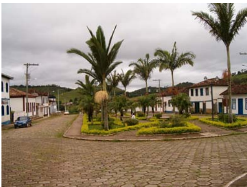
Figura 1.26 – Conjunto de residências
