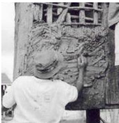
Figuras 4.37. Barreamento da trama
