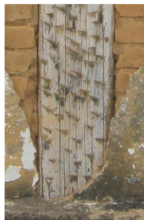
Figuras 5.34. Esteio falquejado
