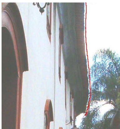
Figuras 5.24. A linha vermelha acompanha a deformação da parede
