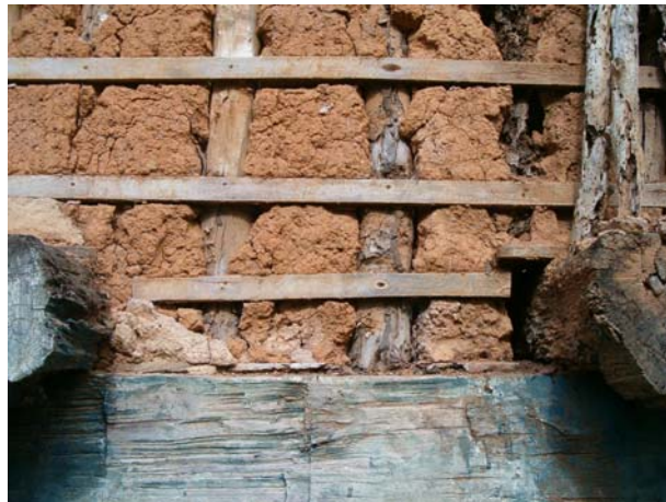
Figura 4.18. Trama constituída por paus verticais roliços e paus horizontais serrados
