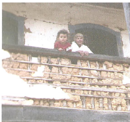
Figura 2.5. Guarda corpo de pau a pique
