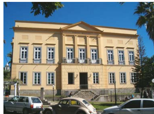
Figura 1.9 – sede da Câmara Municipal que possui paredes internas de pau a pique. Vassouras/ RJ
