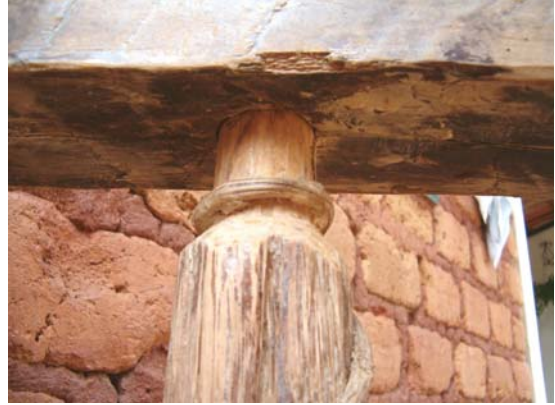
Figura 4.20. Detalhe do encaixe no frechal
