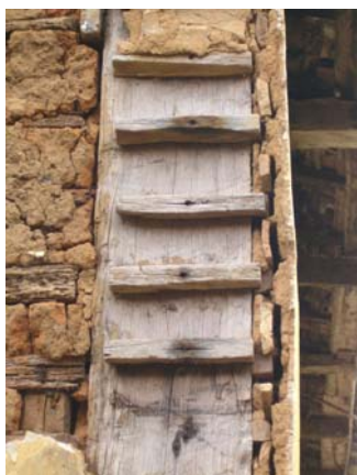
Figuras 5.33. Elementos salientes sobre esteio de madeira
