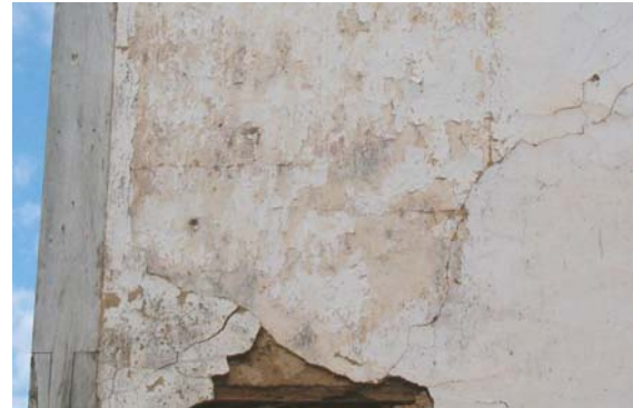
Figuras 5.13 e 5.14. Fissuras no reboco
