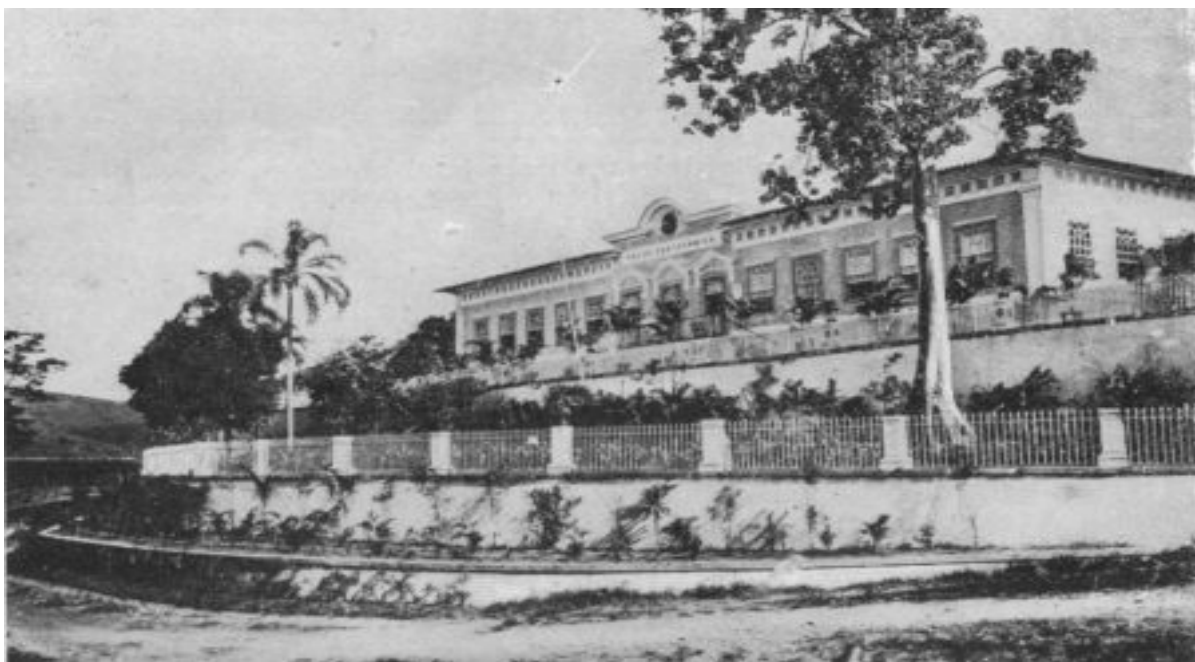
Figura 18 – Vista do prédio principal da Fazenda Pinheiro, onde funcionou o AA Nilo Peçanha a partir de 1941. Ano: 1912. Fonte: disponível em < www.estacoesferroviarias.com.br >, acesso em 19 de ago. 2009.
