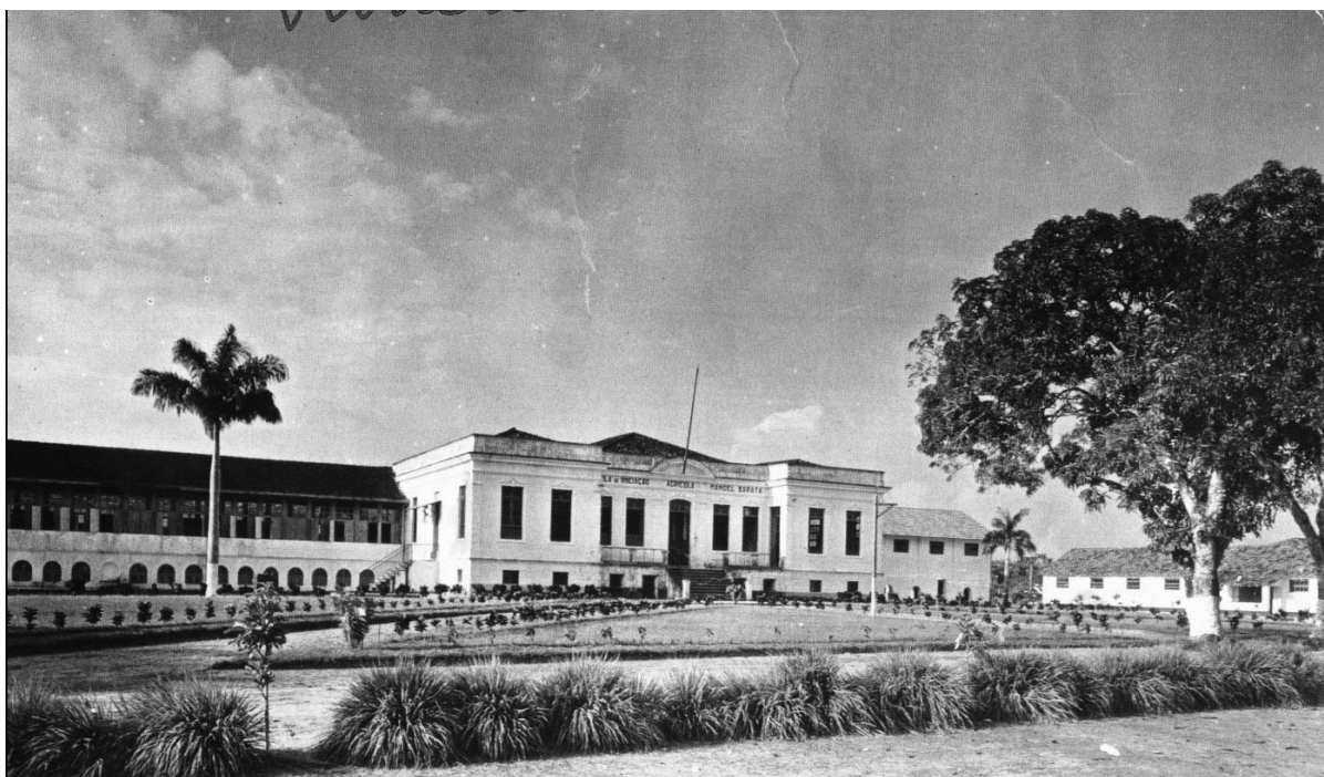
Figura 14 – Vista do prédio principal do Patronato Agrícola Manoel Barata depois Aprendizado Agrícola Manoel Barata, na cidade de Outeiro. Ano: s/d. Fonte: OLIVEIRA, 2007, p. 63.
