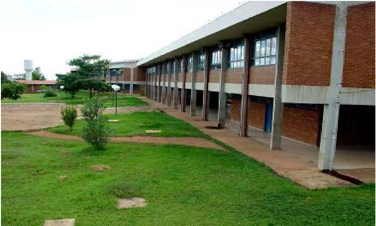
Figura 9: Área interna do CEM
