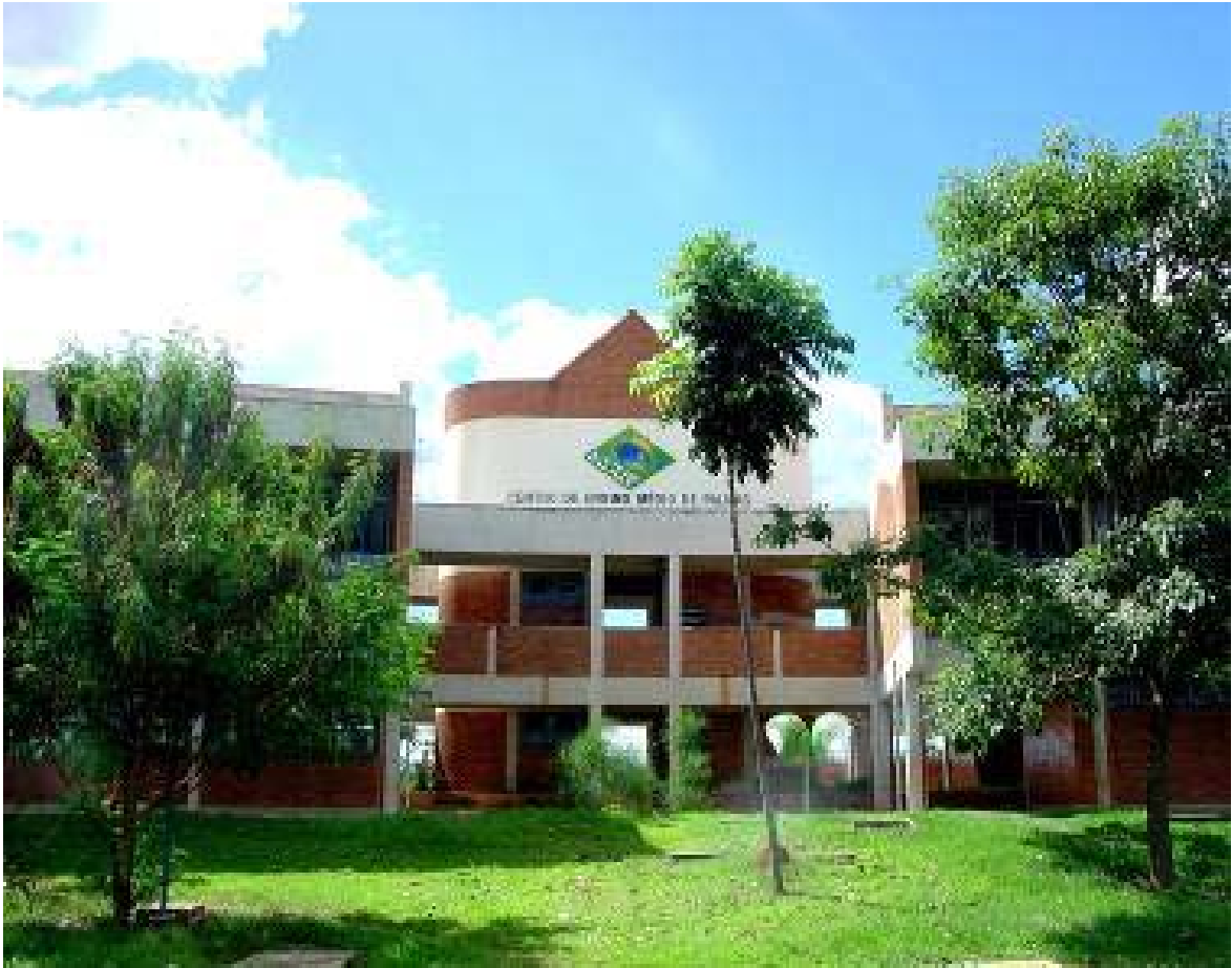
Figura 1 - Fachada do Centro de Ensino Médio de Palmas
