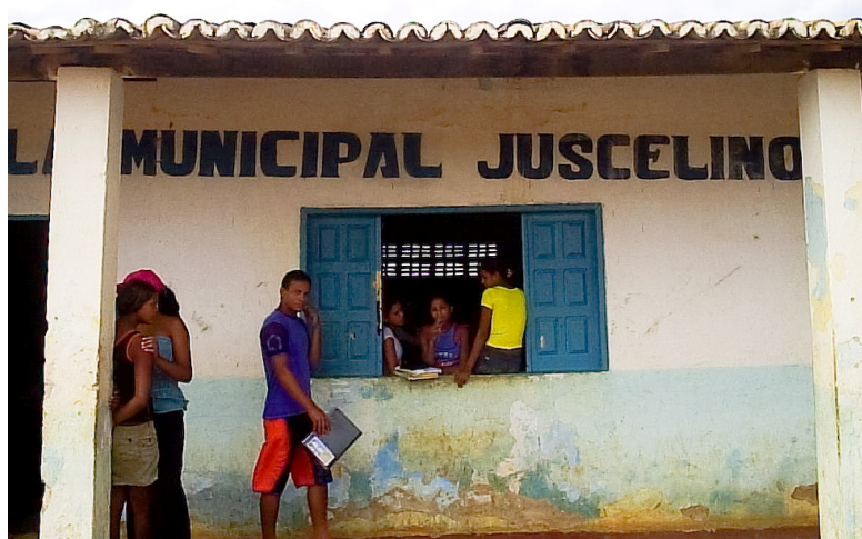
Foto 20 – Espaço interno do Prédio Escolar (13/09/2006)
