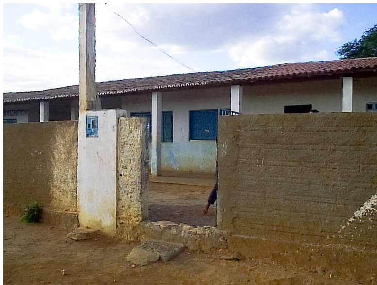
Foto 19 – Entrada do Prédio Escolar, sede do povoado da Vereda (13/09/2006)
