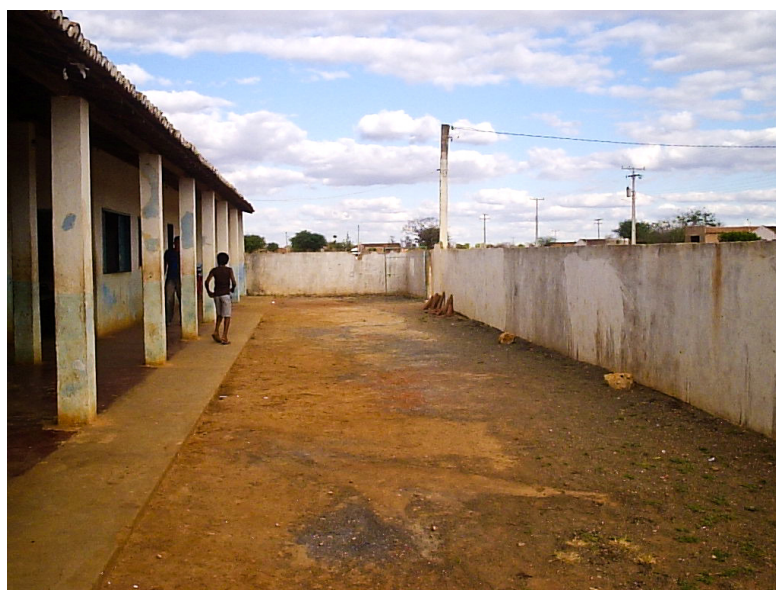
Foto 21 – Espaço interno do Prédio Escolar (13/09/2006)
