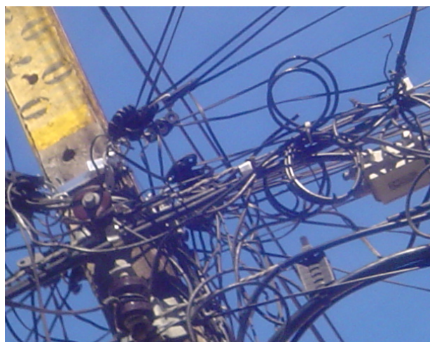
Figura 32 – Poste sustenta um conjunto de redes: TV a cabo e telefone. Fotografia nossa.
