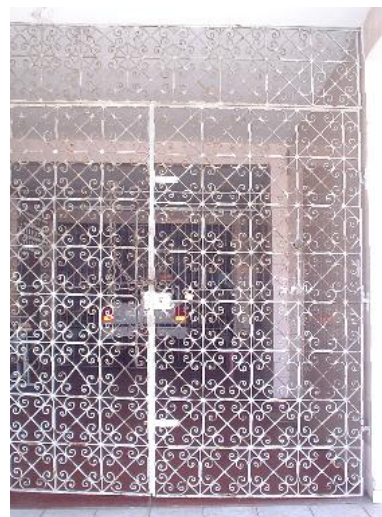
Figura 100 ó Gradil residencial em Itapuã.
