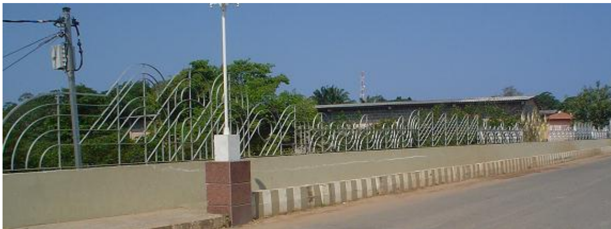
Figura 118 ó Gradil da Ponte do Rio Caji.
