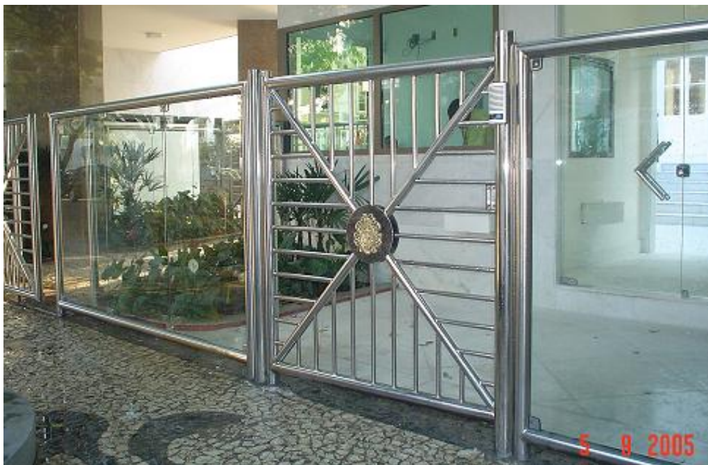
Figura 130 - Gradil do Edifício Margarida Costa Pinto.
