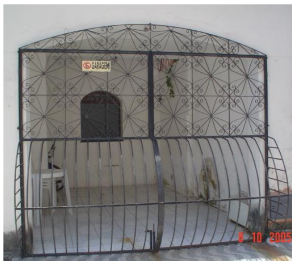
Figura 109 ó Gradil residencial no Bonfim ó portão 2.
