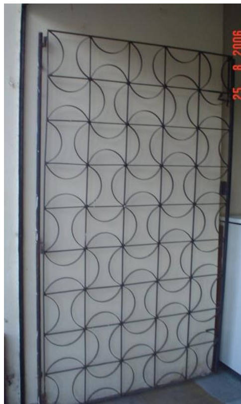
Figura 107 ó Gradil residencial em Lauro de Freitas ó portão 2.
