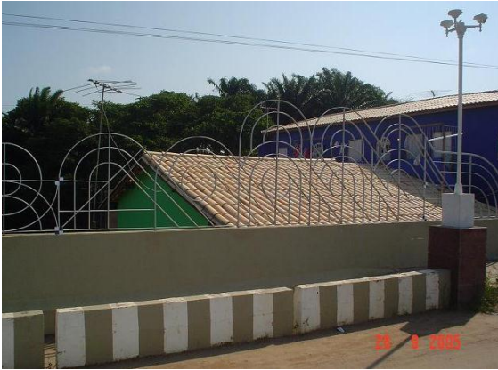
Figura 16 Fotografia parcial do gradil da Ponte do Rio Caji.
