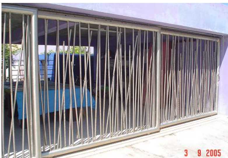
Figura 128 ó Gradil da residência de Ivanildo Barbosa Dias.
