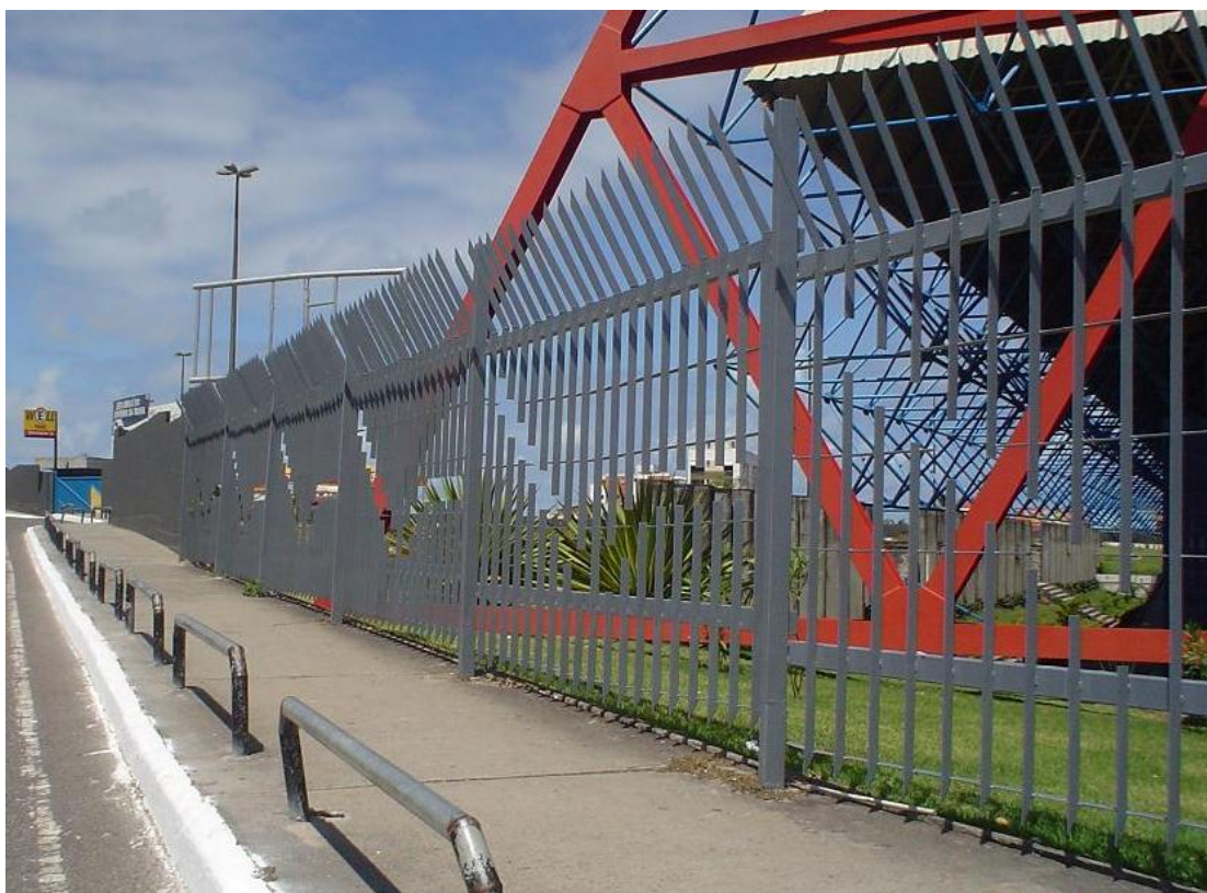
Figura 88 ó Gradil do Centro de Convenções.
