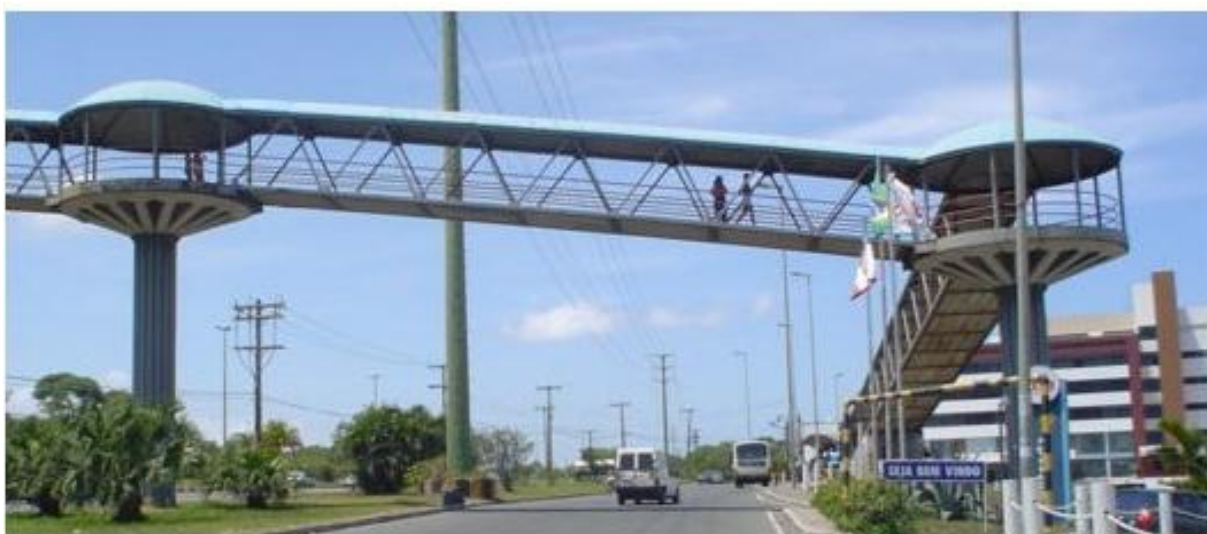
Figura 125 ó Gradil da Passarela Urbana ó FAEC.
