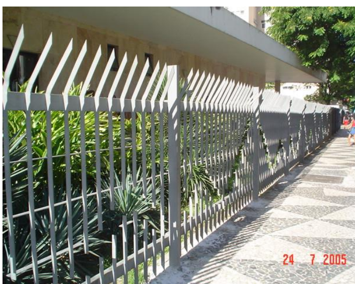
Figura 87 ó Gradil do Teatro Castro Alves.
