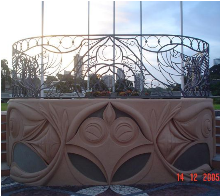
Figura 56 ó Hospital Aliança ó Gradil Coreto.
