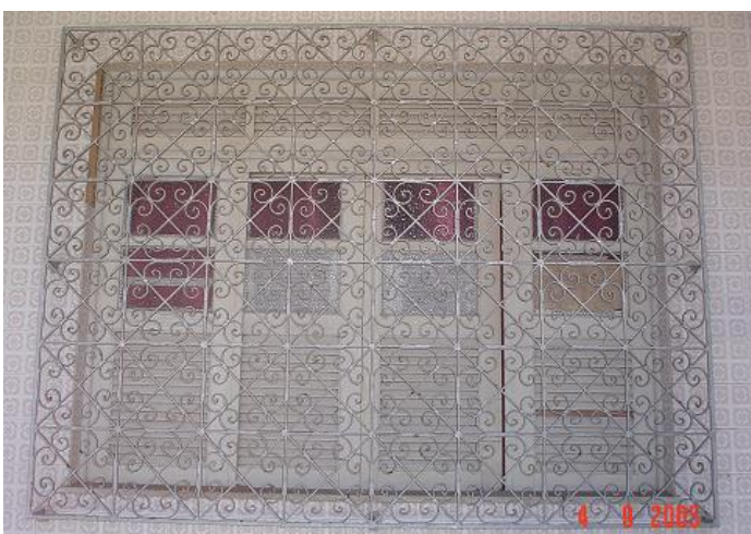
Figura 99 ó Gradil residencial em Itapuã.
