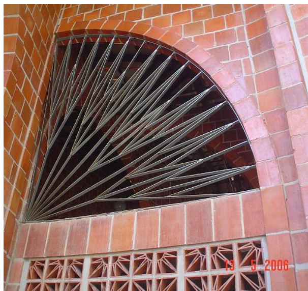
Figura 116 Ó Gradil da Escola Acalento ó Detalhe.
