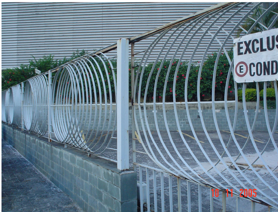
Figura 92 ó Gradil do Edifício Residencial Beta.
