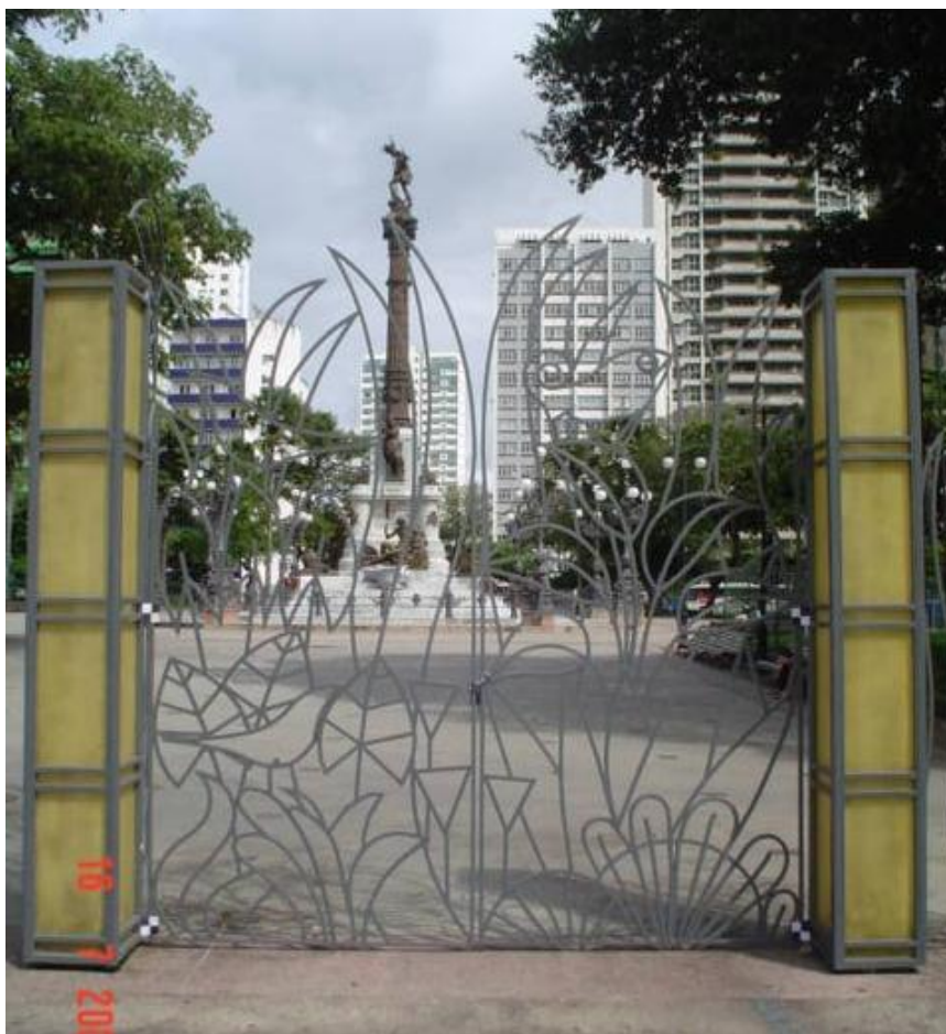
Figura 69 é Gradil da Praça Dois de Julho é portão.
