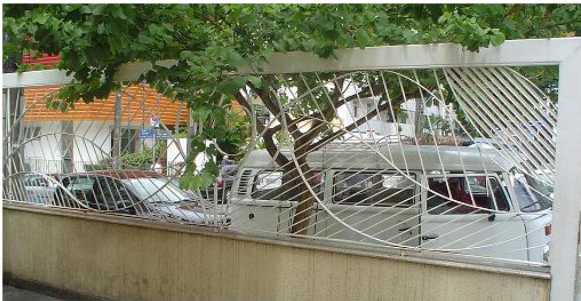
Figura 77 ó Gradil do Canela e Cia Restaurante.
