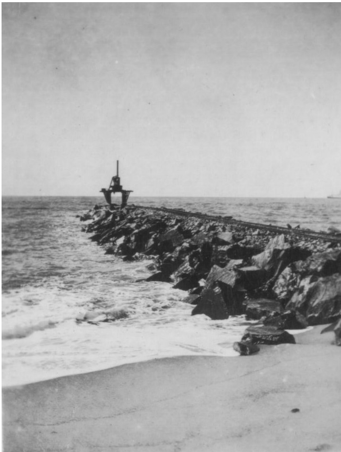
Fotografia 55 – Flagrante da construção dos diques de proteção contra ressacas. 1960 98
