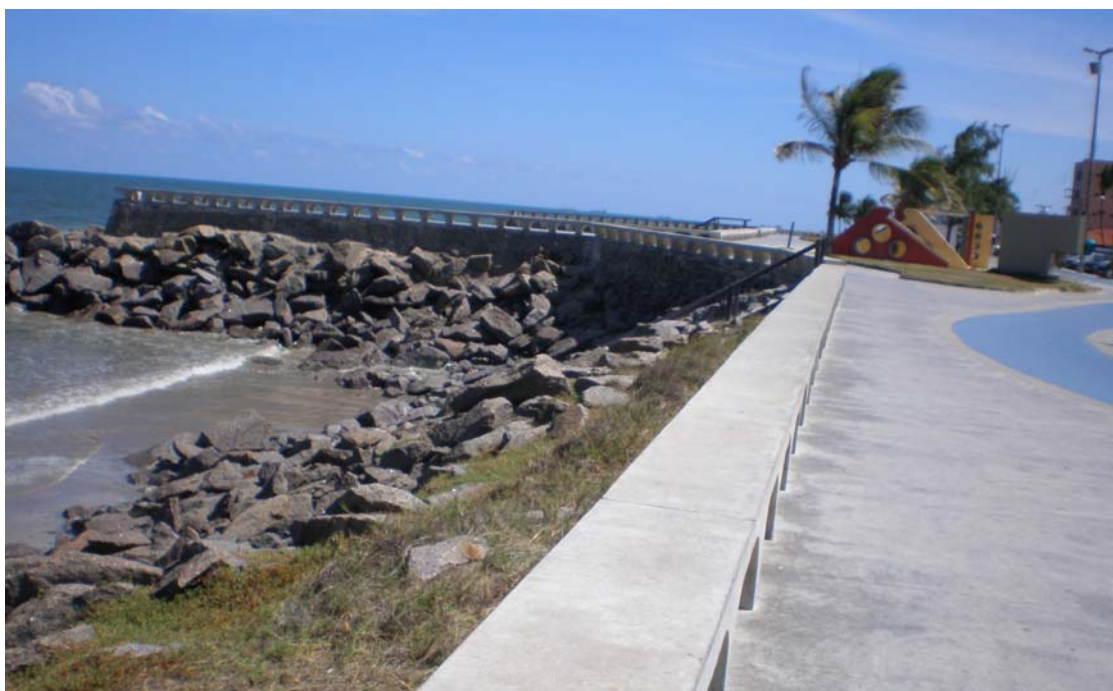
Fotografia 61 – Dique de proteção na praia do Bairro Novo, 2008 111
