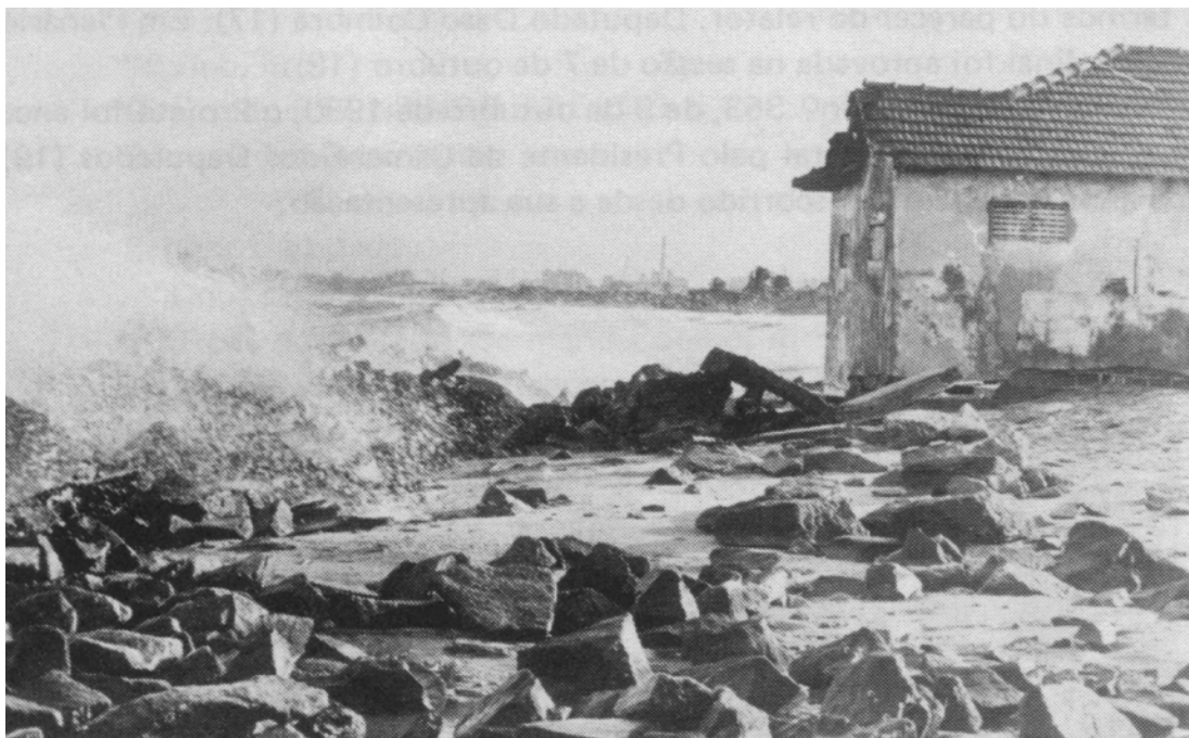
Fotografia 51 – Praia dos Milagres e suas casas de veraneio destruídas pelo avanço do mar, 1960 a 1963 87
