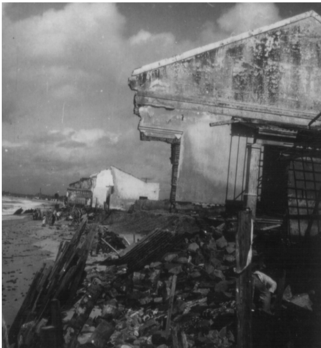
Fotografia 53 – Destruição das casas pelas ressacas do mar em Olinda, na praia dos Milagres. Década de 1960 92
