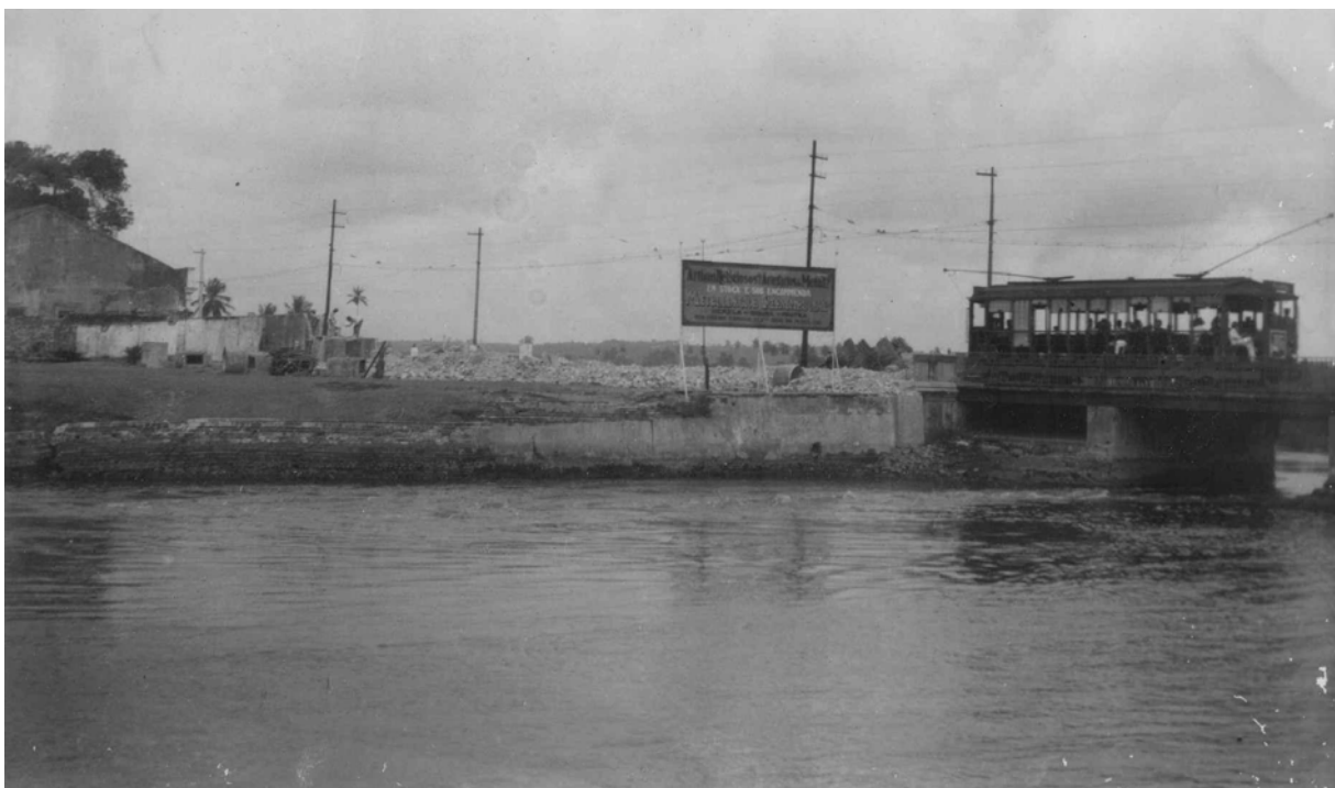
Fotografia 34 – Bonde elétrico na ponte do Varadouro, 1930 49
