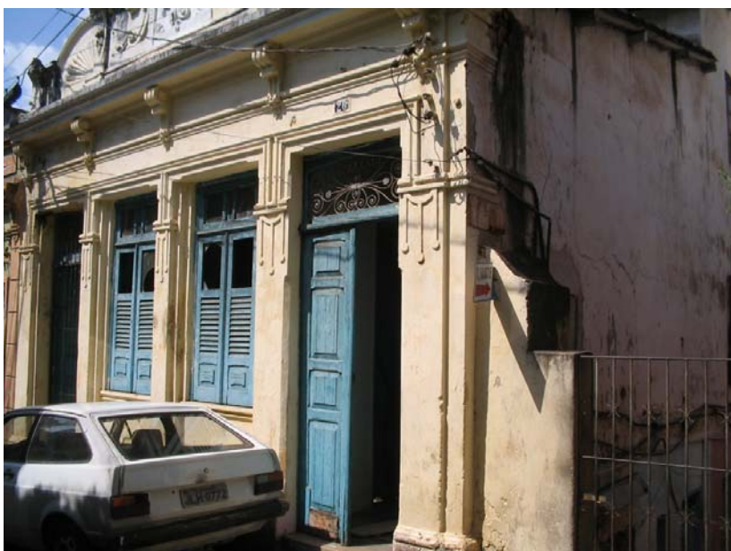
Entrando neste portão lateral, chega-se às lojas, transformadas em abrigo gratuito por Cosme para pessoas sem lar. Sem data. Crédito: Mônica Celestino
