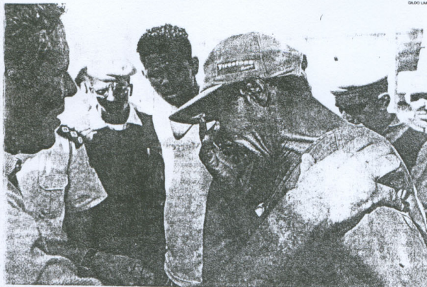
Diante dos apelos da população, o operador emocionado negou-se a concluir a demolição e a casa permaneceu em pé
