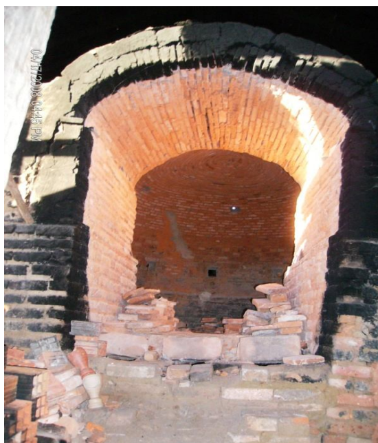
FIGURA 11 – Forno do tipo capela
