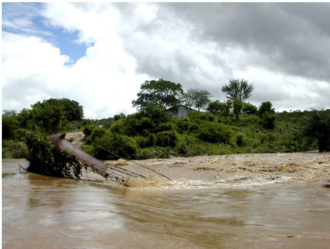
Figura 4 – Rio Kariús: ponte de ferro arrastada
