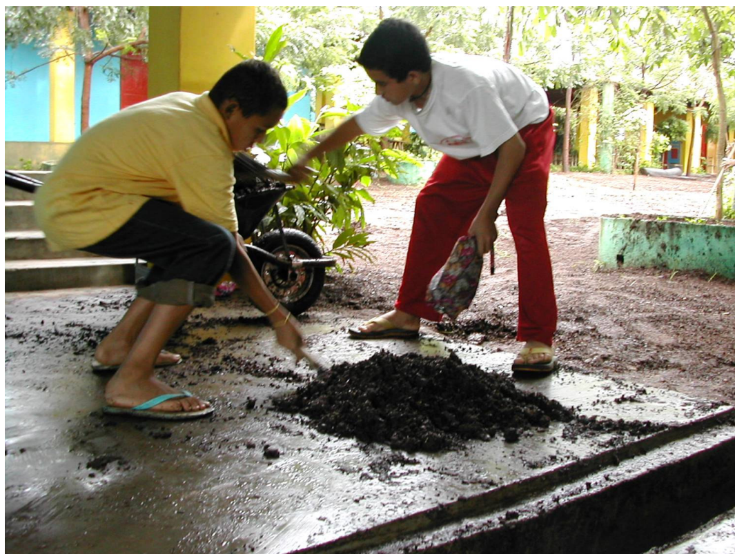
Figura 7 – Estragos da chuva na Casa Grande: esgotamentos entupidos
