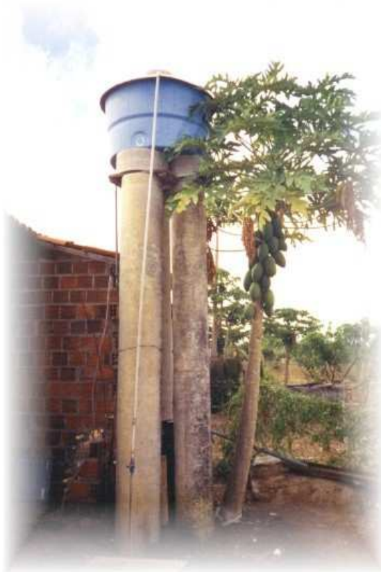
Figura 21: Utilidade dada às tubulações abandonadas no Núcleo.
