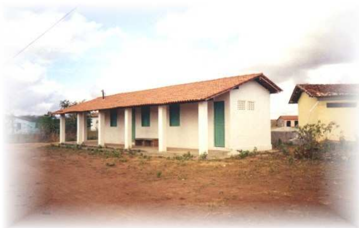
Figura 24: Vista externa da Unidade de Saúde recuperada.
