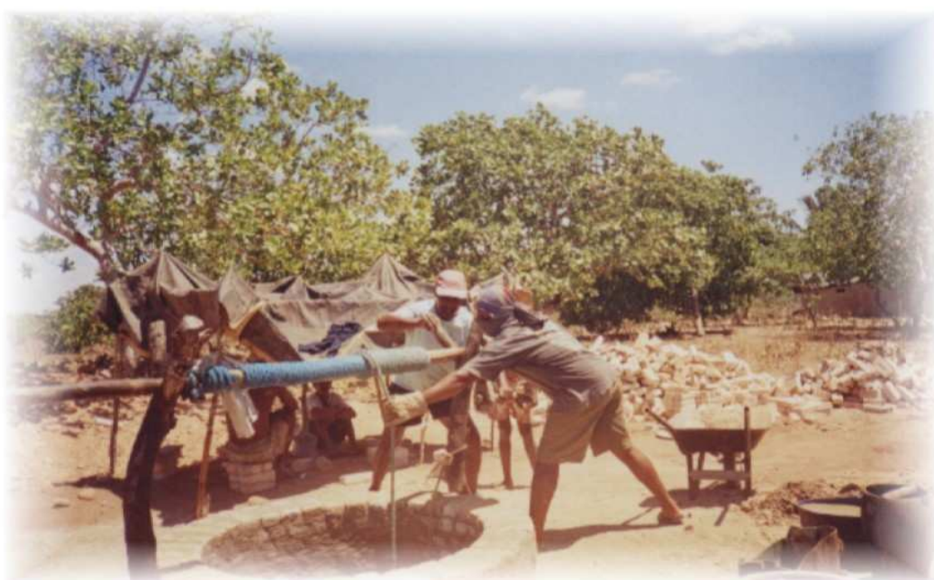
Figura 14: Cavando uma cisterna.
