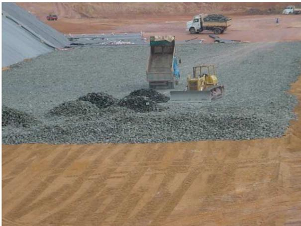
Figura 11 - Construção da camada drenante de lixiviado
