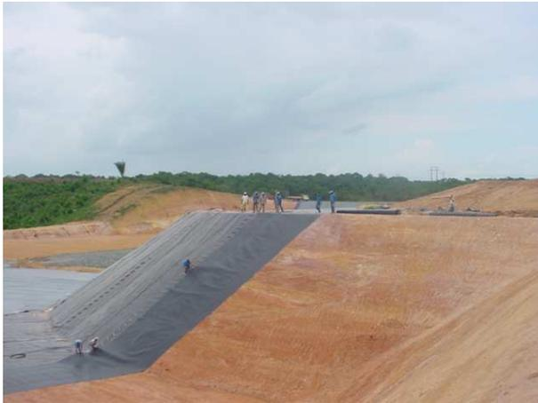
Figura 09 - Colocação de geomembrana sobre o talude de uma célula de RSU no ASMC
