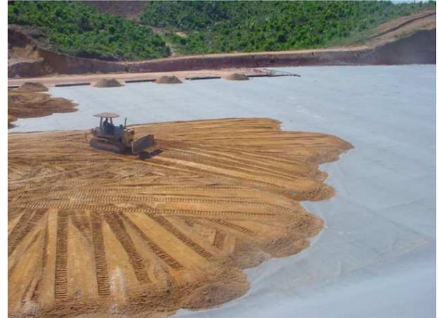
Figura 08 - Colocação de uma camada de proteção mecânica sobre a geomembrana
