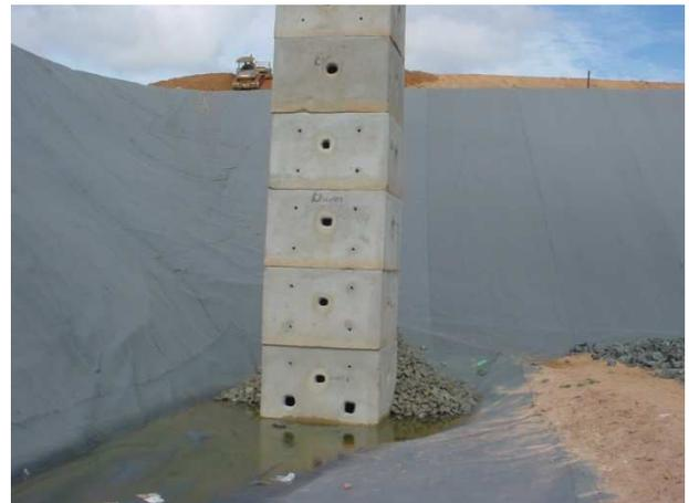
Figura 12 - Implantação de aduela celular para captação e bombeamento do lixiviado
