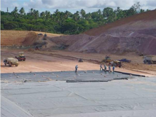
Figura 07 - Colocação da geomembrana sobre uma camada de argila compactada
