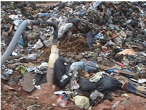
Figura 16 - Sistema de captação do biogás instalado nas células do ASMC
