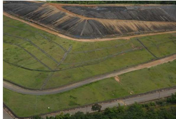
Figura 15 - Vista aérea da camada de cobertura construída em uma célula de RSU no ASMC
