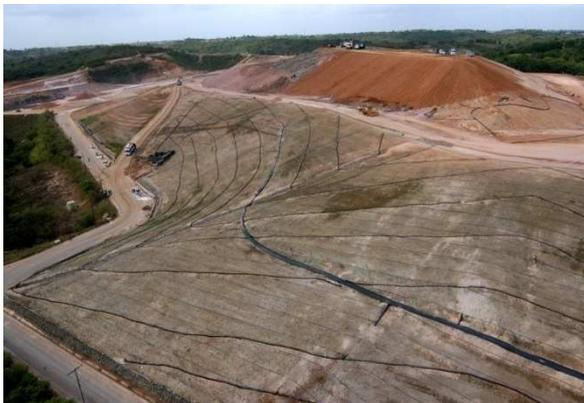
Figura 14 - Vista aérea da construção da camada de cobertura em uma célula de RSU no ASMC
