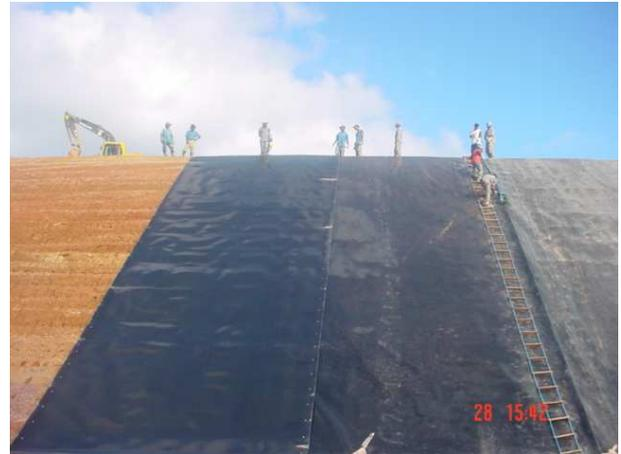
Figura 10 - Revestimento do talude de uma célula no ASMC
